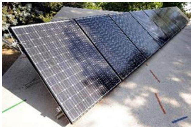
Figura 2.16 – Exemplo de sombreamento parcial Fonte: COSOL, 2017
