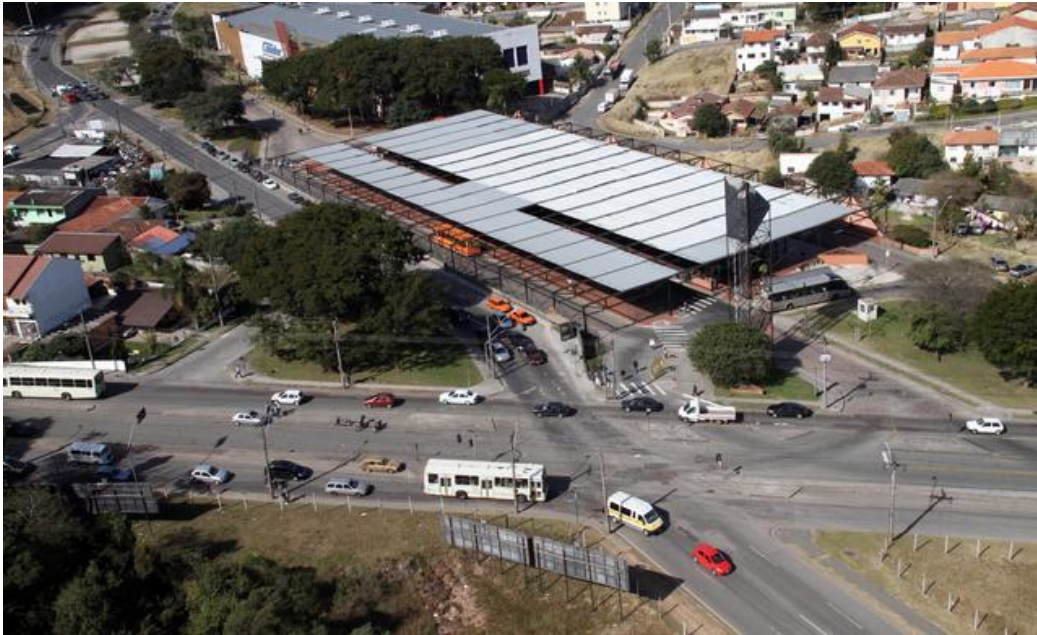
Figura 42—Terminal do Santa Cândida.
