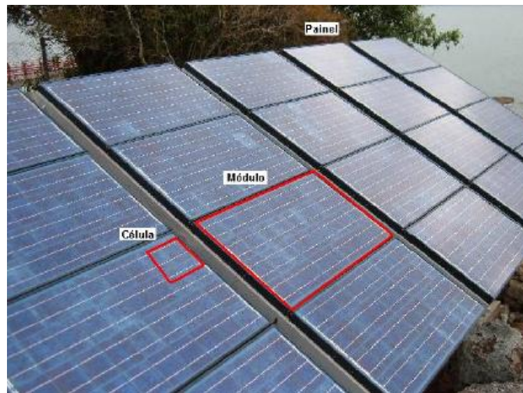
Figura 17– Célula, Módulo e Painel Fotovoltaico.
