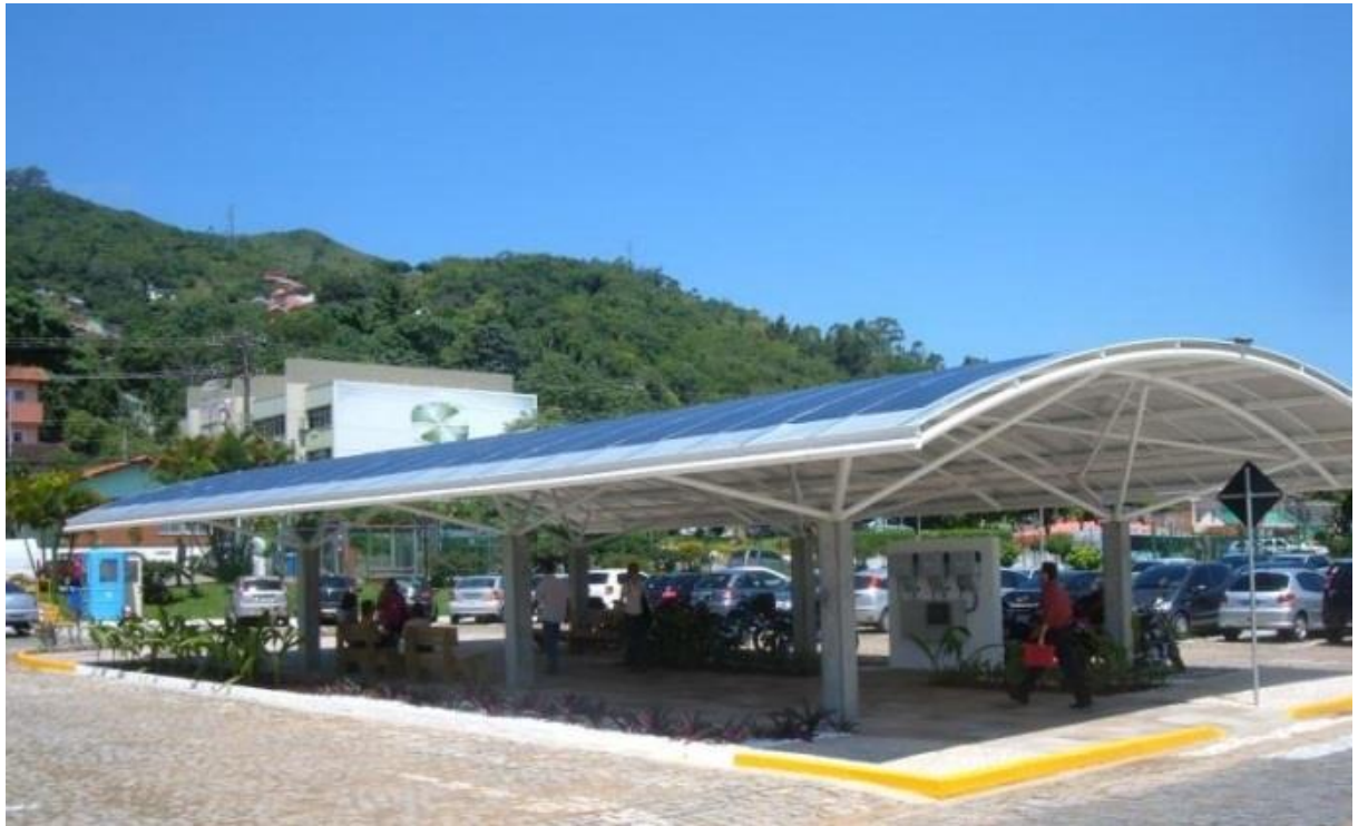
Figura 48– Aplicação da tecnologia da célula de silício amorfo.
