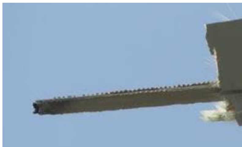
Figura 20 - Exemplo de dano causado por separação das pontas da pá de aerogeradores Fonte: N. WILSON, 2013
