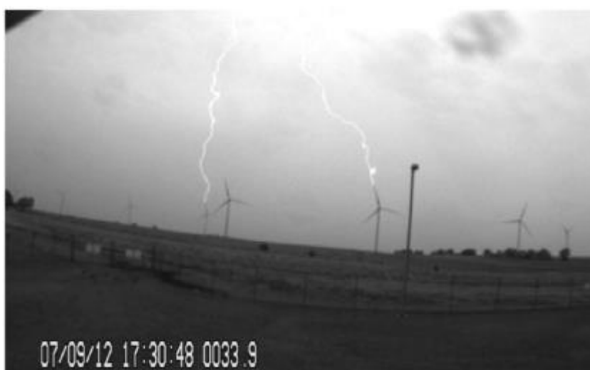
Figura 15 - Raios atingindo aerogeradores no Parque Eólico Central de Kansas, EUA. Fonte: N. WILSON, 2013
