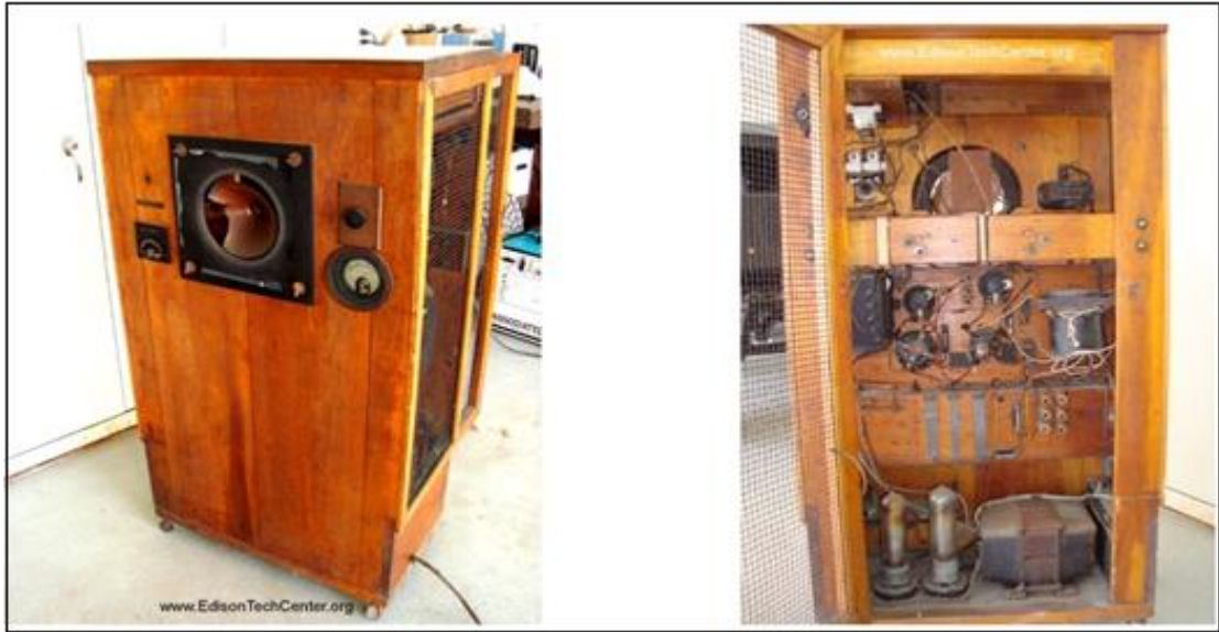
Figura 18 - O primeiro protótipo de um alto-falante dinâmico. Fonte: EdisonTech Center (2015).
