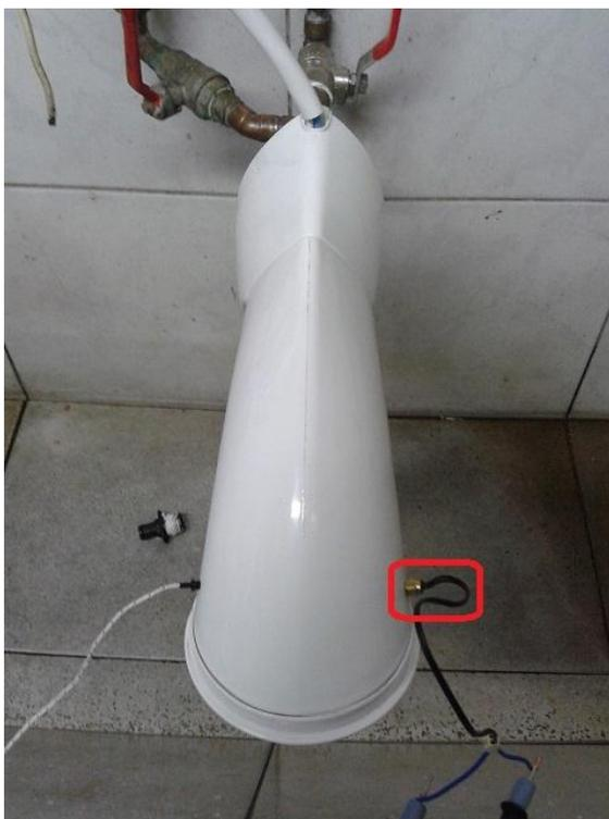
**Figura 32 - Foto do sensor NTC instalado no chuveiro**
