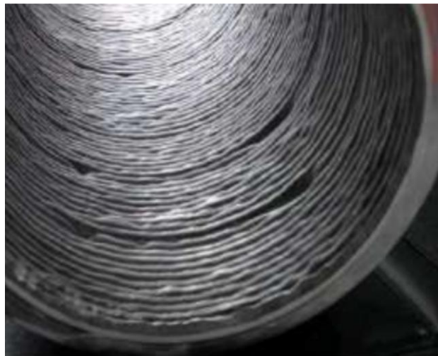
Figura 18 - Tubo com Inconel depositado internamente. Fonte: Núcleo Inox, 2010.
