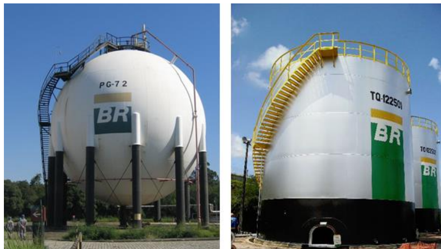
a) Tanque esférico
