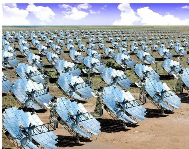
**Figura 2.10 – Planta de discos parabólicos na Califórnia, EUA.**
