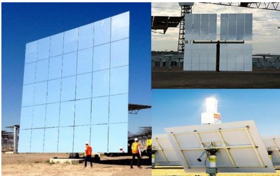
**Figura 2.11 – Heliostatos de diferentes tamanhos e formatos.**
