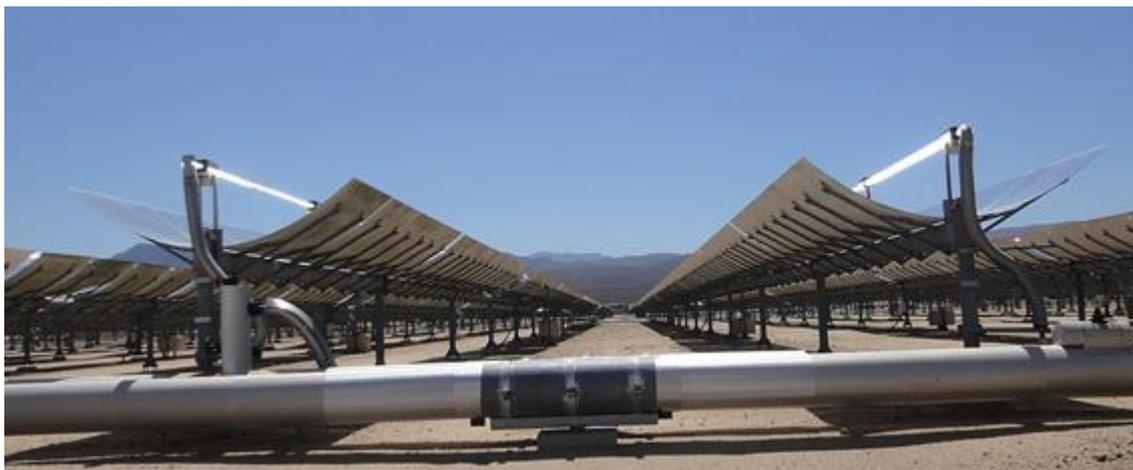
**Figura 2.6 – Calhas parabólicas da usina SEGS II, em Daggett.**
