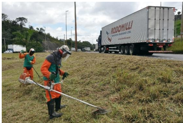
Figura 4 - Capina mecânica em beira de rodovia. Fonte: (Prefeitura de contagem, 2017).
