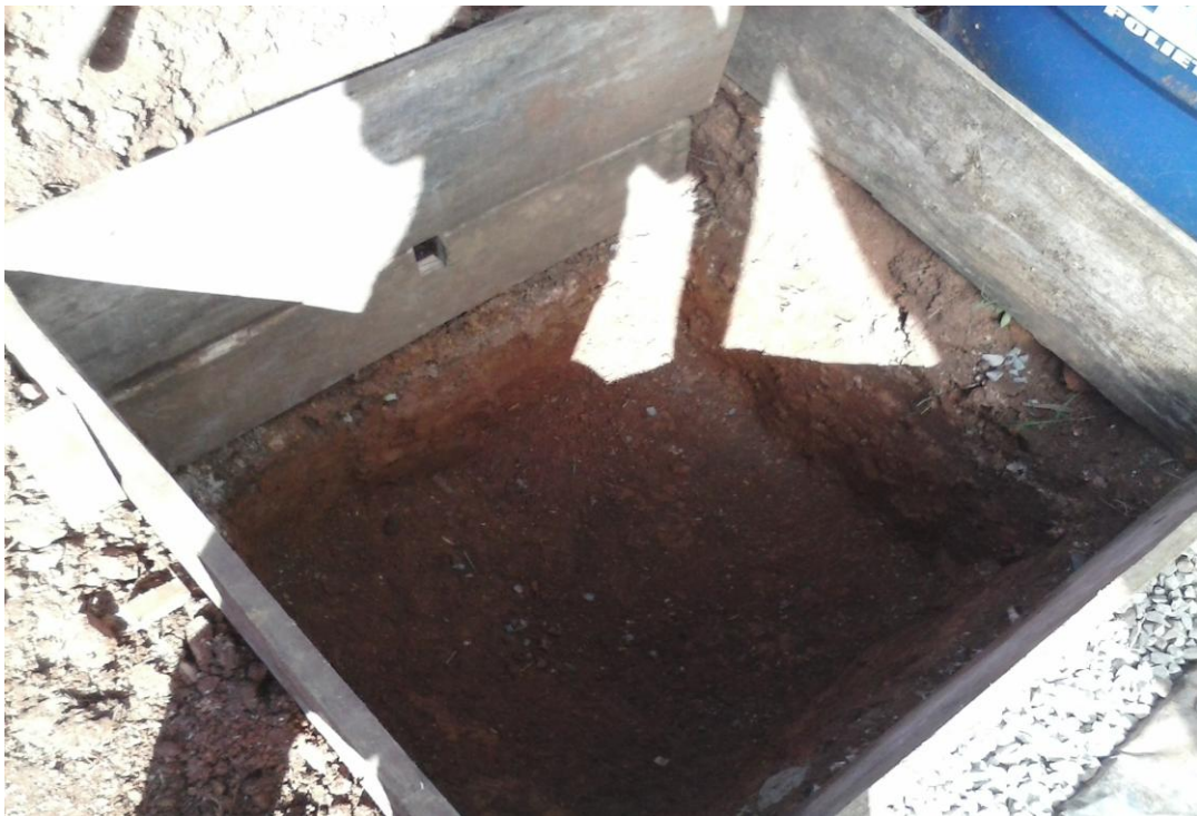
Figura 5: Estrutura do tanque artificial para criação de Tilápia. Fonte: (O Autor).
