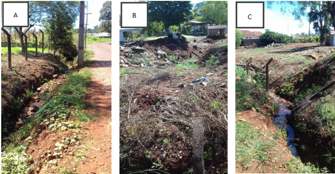
Figura 16 - A); B); C): Córrego localizada próximo ao Pesque Pague.
