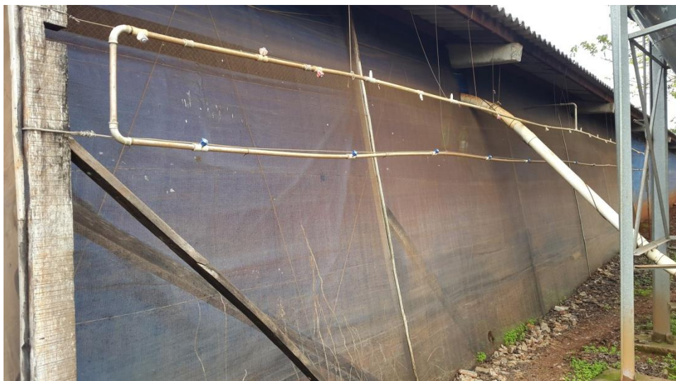
Figura 4: Sistema de resfriamento.
