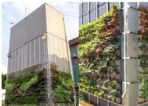
Figura 3 – Parede viva no prédio da UNICAMP/SP
