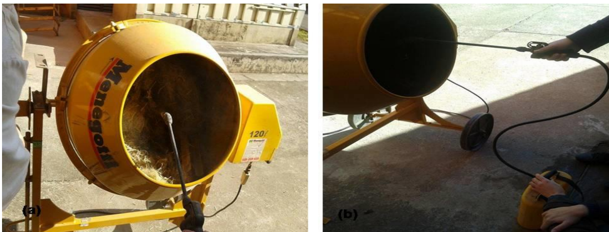
Figura 18. Material sendo misturado na betoneira
