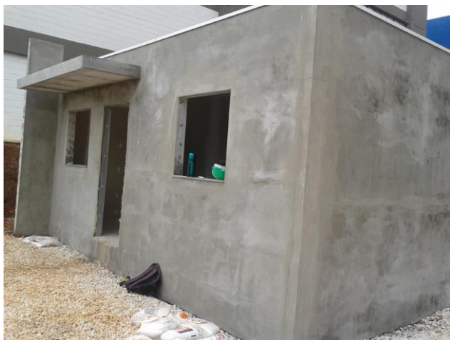
Figura 9. Casa construída de painéis de cimento-madeira (UTFPR)
