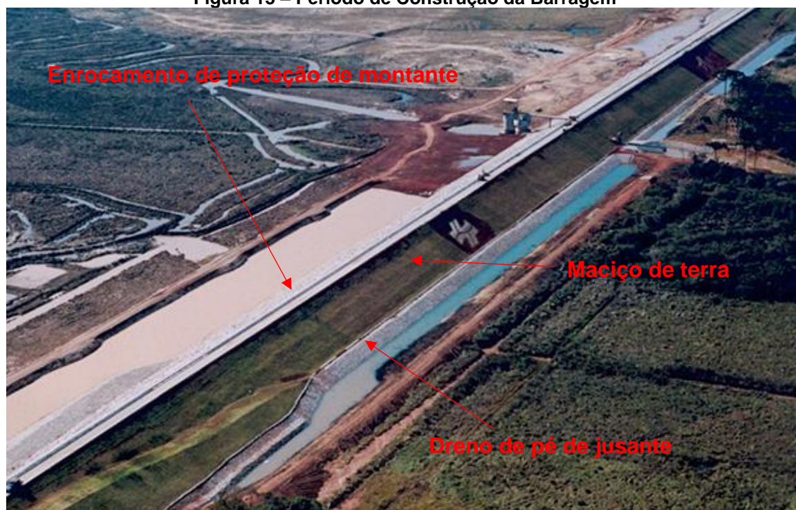
Figura 13 – Período de Construção da Barragem
