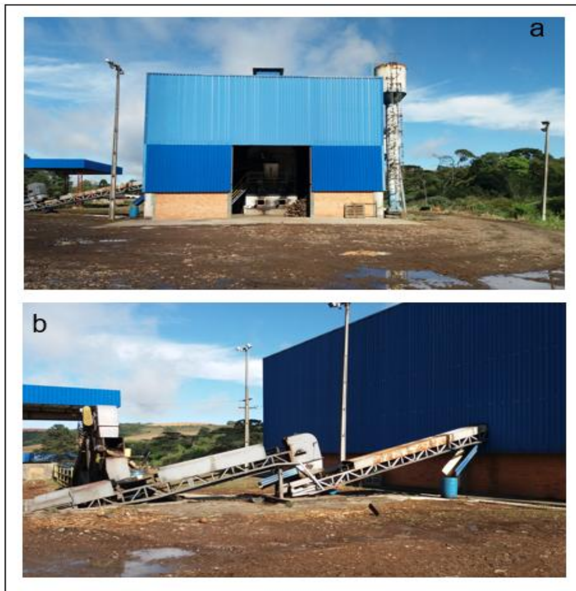
Figura 06 – (a) Prédio da Caldeira de Biomassa e (b) Transporte de cavaco da Caldeira de Biomassa Fonte: Autoria própria
