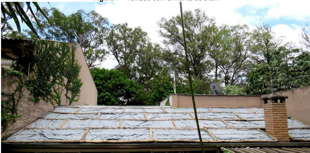
Figura 7 - Telhado com a manta de bidim
