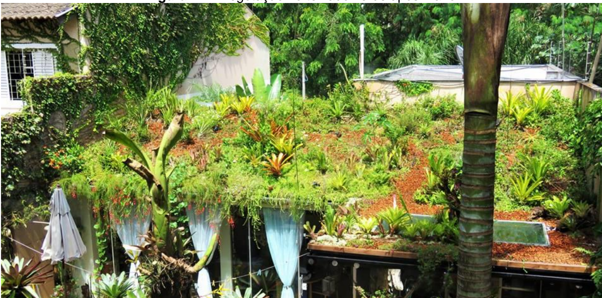
Figura 11 – Vegetação no telhado verde após 1 ano.
