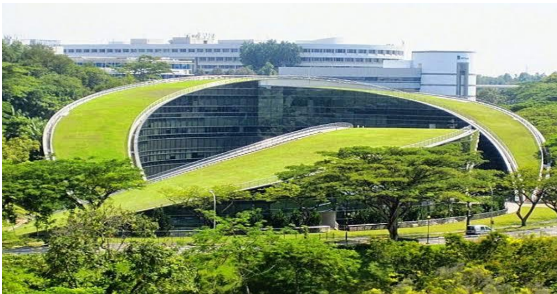
Figura 1: Telhado verde da Universidade Tecnológica de Nanyang
