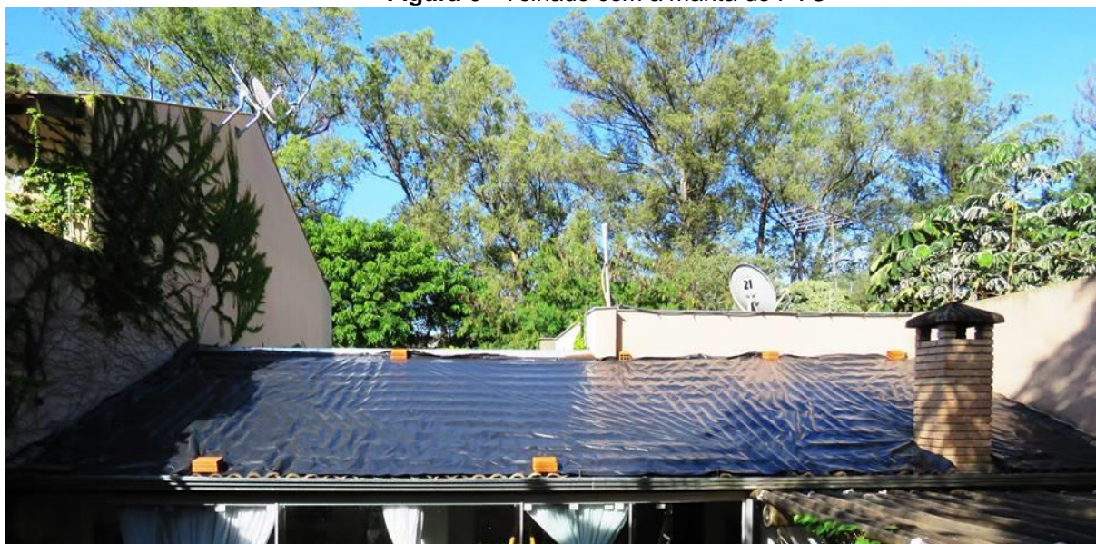
Figura 6 - Telhado com a manta de PVC
