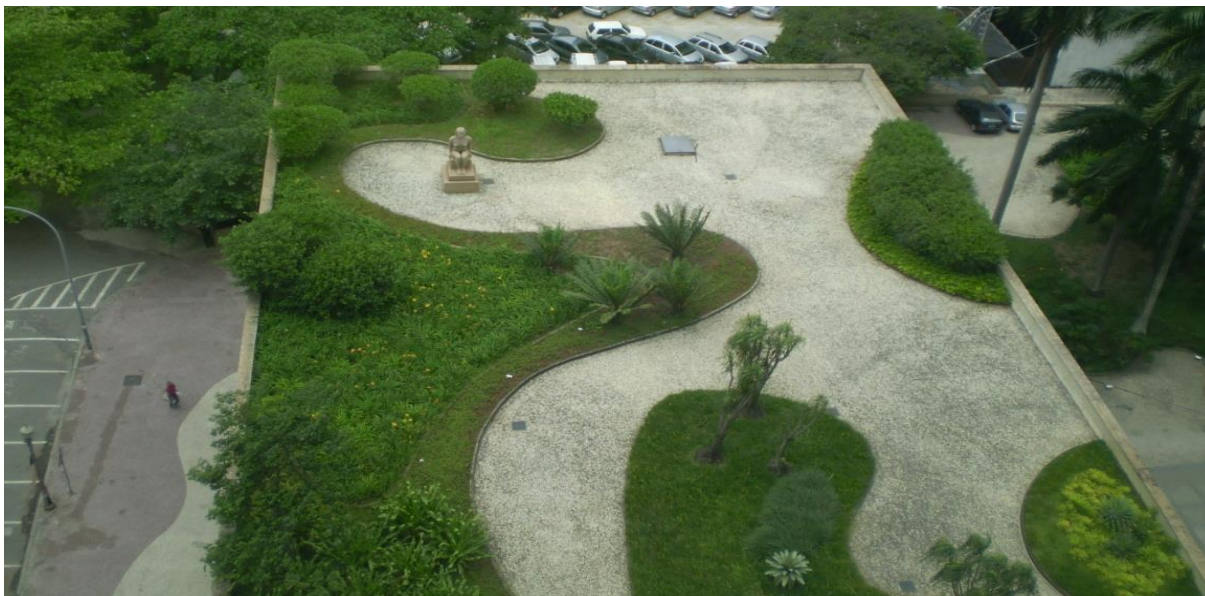
Figura 2: Primeiro telhado verde do Brasil, prédio do Ministério de Saúde e Educação, RJ.
