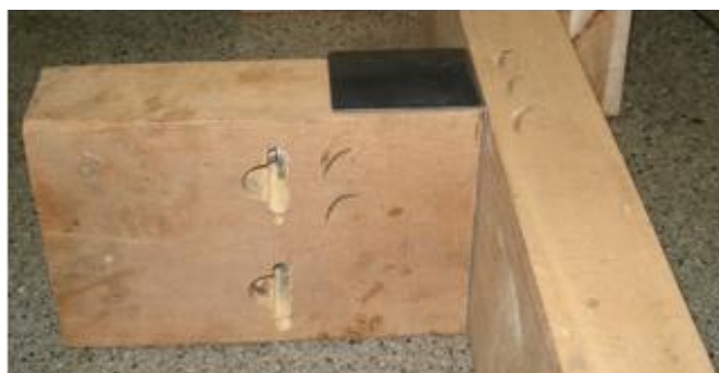
Figura 25 – Posição da furação lateral e da chapa dobrada. Fonte – Arquivo do autor.
