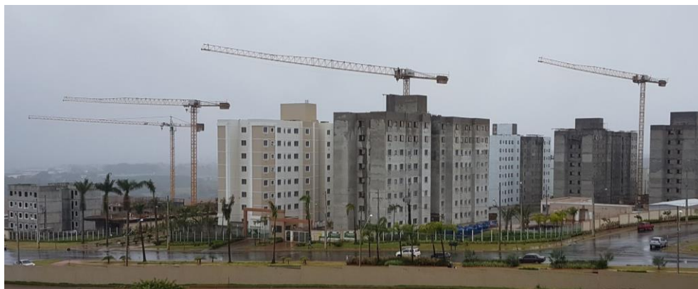
Figura 2 - Grua em construção de condomínio
