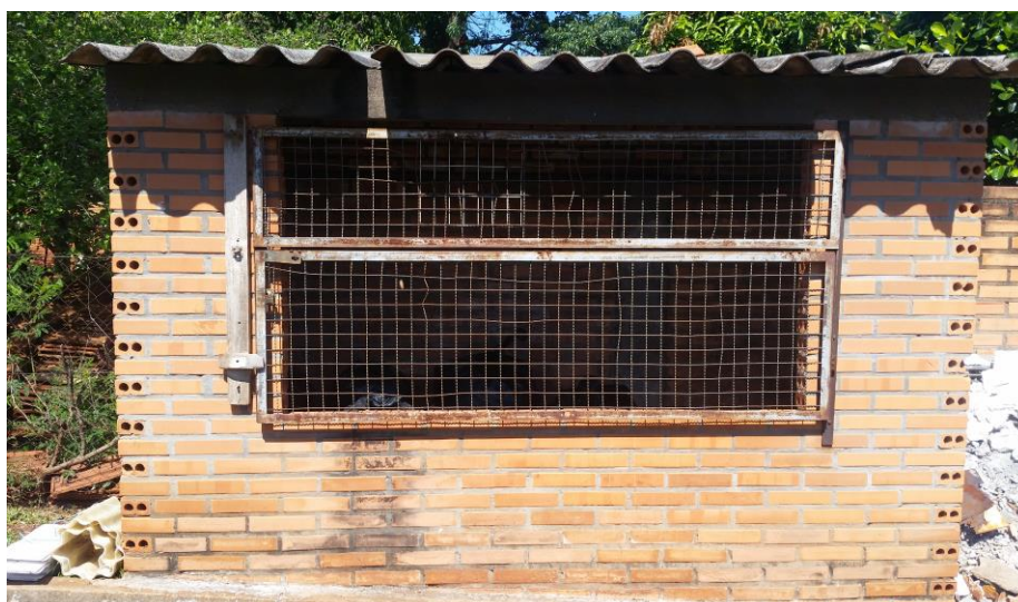
Figura 11 - Local de Acondicionamento dos resíduos provenientes das Salas de Aula, Corredores, Banheiros e Unidades de Apoio.
