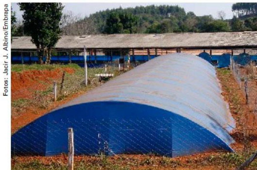
Figura 11 - Reservatório em PEAD
