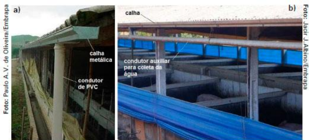
Figura 4 - Exemplos de calha coletora e condutor auxiliar em telhados de granjas Fonte: Documentos 157 – Embrapa (2012)
