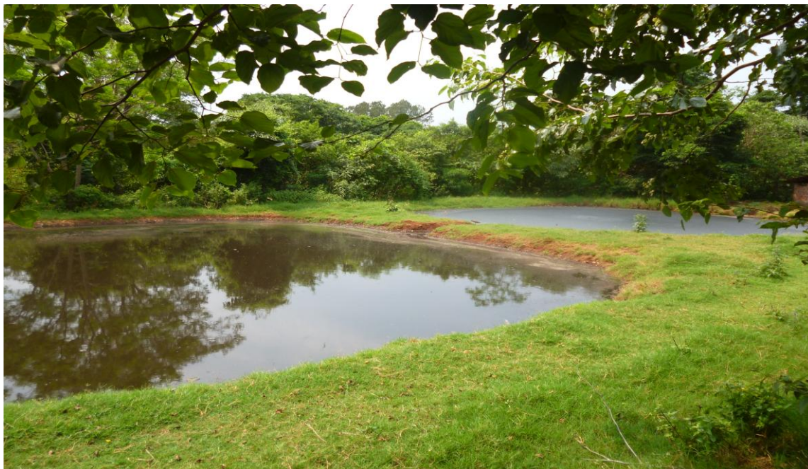
Figura 13 - Sistemas de armazenamento (esterqueiras)
