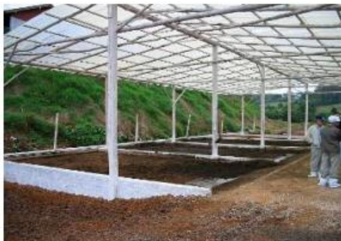
Figura 16 – Compostagem – câmaras de incorporação de dejetos líquidos em leito de maravalha.
