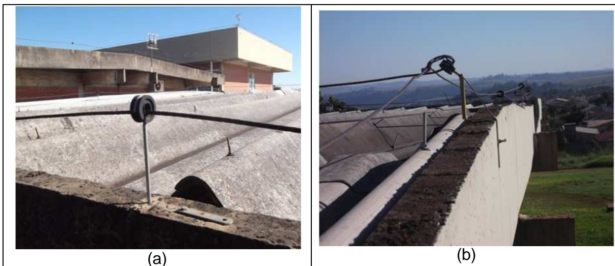
Figura 29 – Bloco I2, espaçador do subsistema de captor com base quebrada (a), e Bloco I4, espaçador do subsistema de captor com base quebrada e outro torto (b) Fonte: Autor
