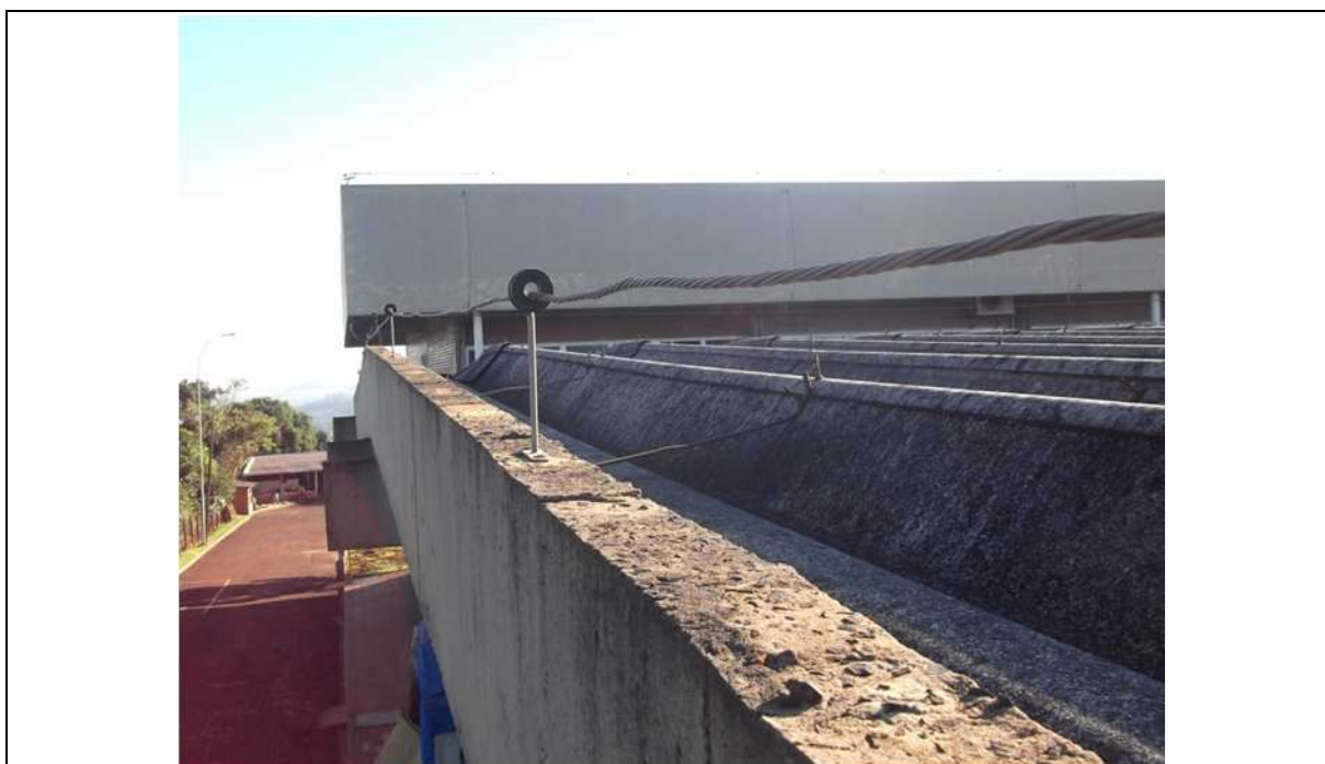
Figura 22 – Bloco J2, captos instalados com espaçadores Fonte: Autor.
