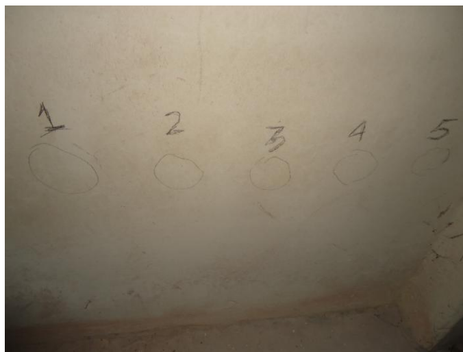
Figura 22 - Região C (fachada norte) Fonte: Autoria própria.
