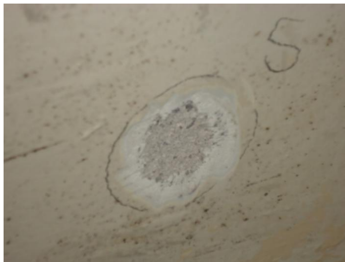
Figura 24 - Remoção do material superficial da parede até o revestimento em argamassa Fonte: Autoria própria.
