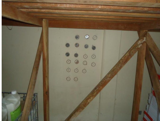
Figura 23 - Região E (fachada oeste) do almoxarifado Fonte: Aatoria própria.
