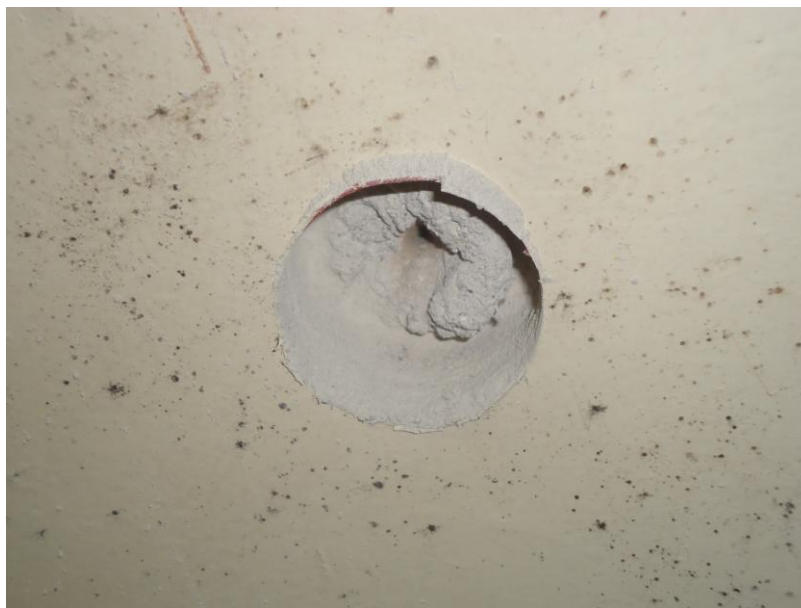
Figura 19 - Região B com evidência de bolor Fonte: Autoria própria.
