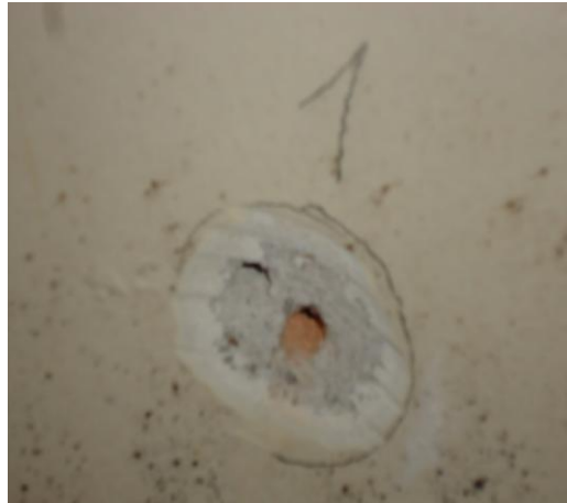
Figura 27 - Detalhe da raspagem do reboco até o encontro do revestimento de bloco cerâmico Fonte: A autoria própria.
