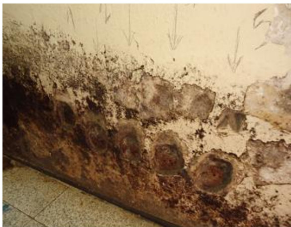
Figura 28 - Manifestação de bolor e alto teor de umidade na Região A Fonte: Autoria própria.
