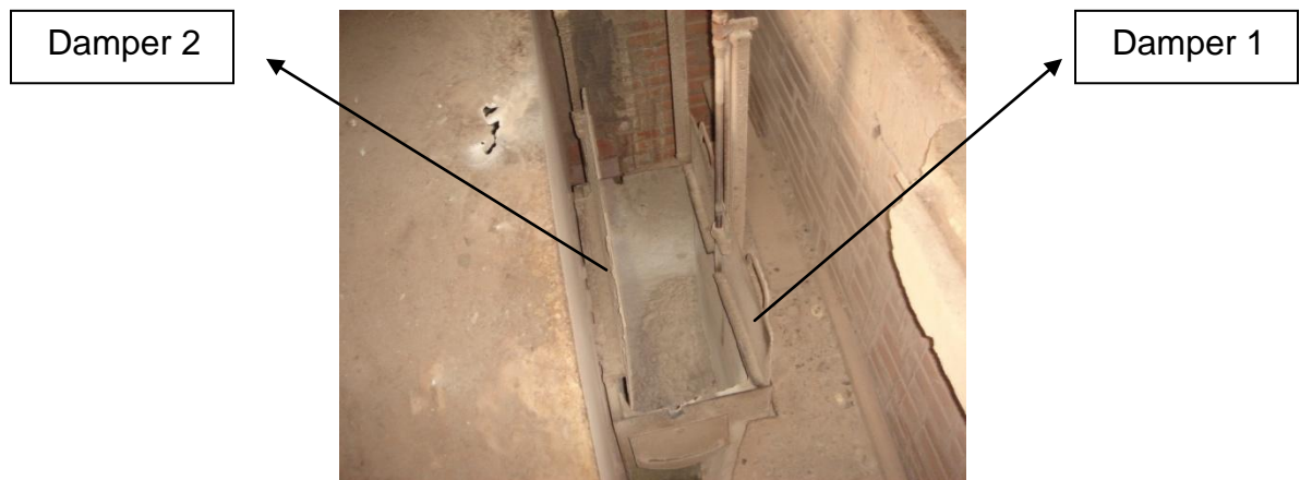
Figura 6 – Identificação dos dampers
