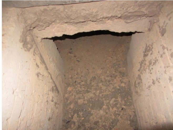
Figura 3 – Canal de concreto
