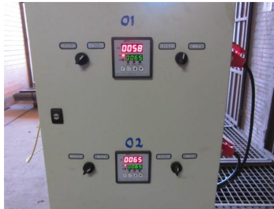
Figura 22 – Indicador e controlador digital de temperatura
