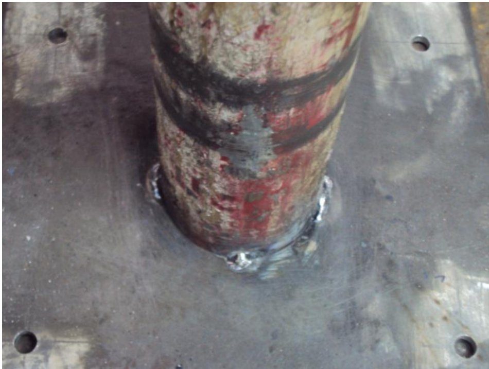
Figura 9 – Chapa soldada no tubo Fonte: Própria
