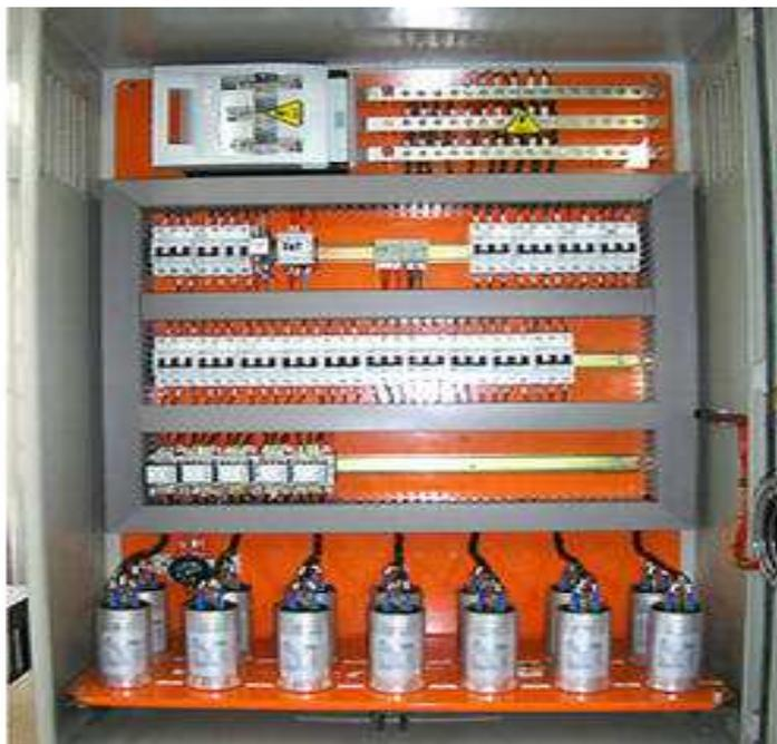
**Figura 2 – Banco de Capacitores industriais**
