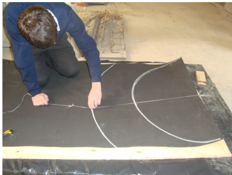
Figura 8 – Preparo do EVA para corte Fonte: Autoria própria, 2013.
