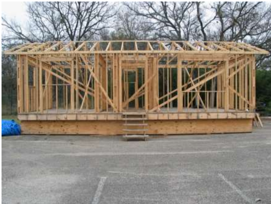
Figura 16 - Estrutura para Wood Frame Fonte: CONSTRUINDO DECOR, 2018.
