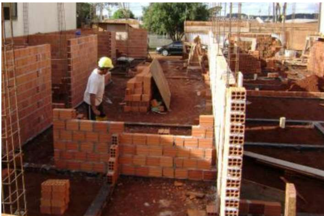
Figura 19 - Exemplo de construção em alvenaria convencional Fonte: AMBIENTALLE, 2011.
