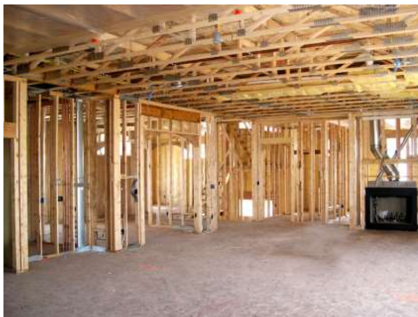
Figura 17 - Interior de um pavimento inteiro em madeira Fonte: CONSTRUINDO DECOR, 2018.
