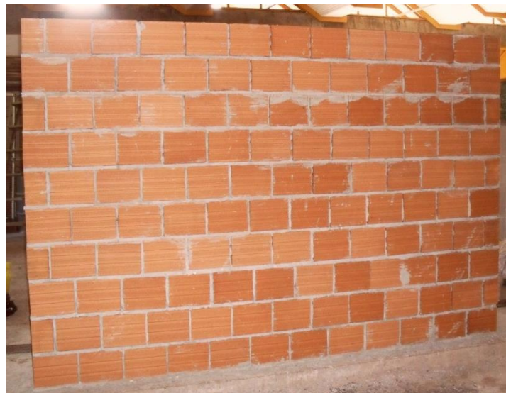
Figura 8 - Paredes de alvenaria de 3x 2 m.
