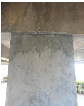
**Figura 94 - Aspecto do pilar rehabilitado**
