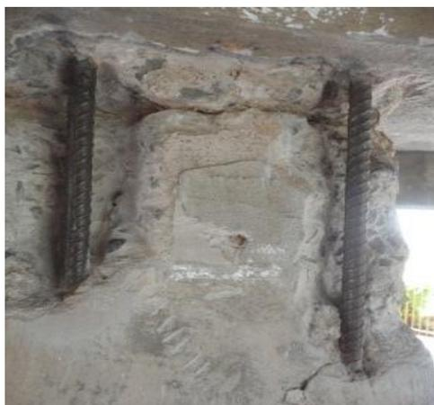
**Figura 90 - Observação da área de aço comprometida pela corrosão**
