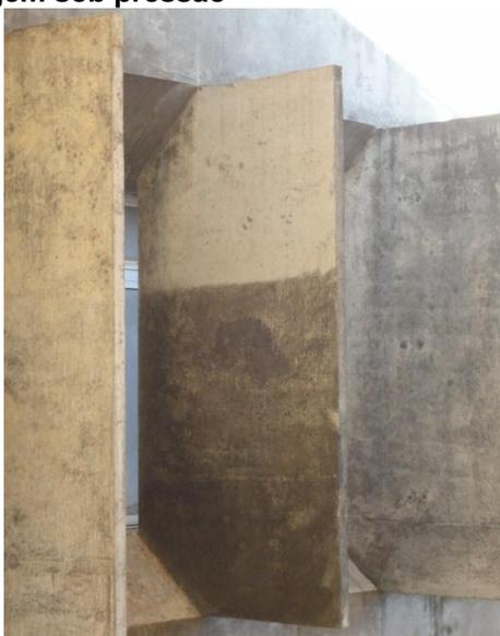
**Figura 97- Aplicação de Resina acrílica**
