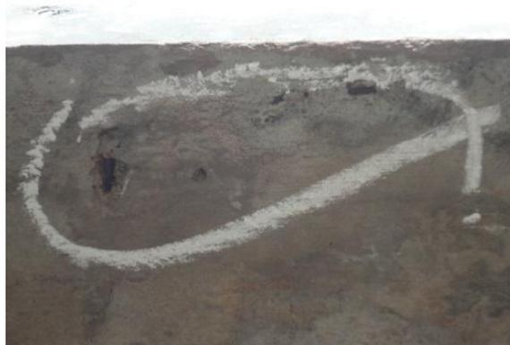
**Figura 18 - Espessura de cobertura insuficiente, corrosão da armadura em borda de viga externa**
