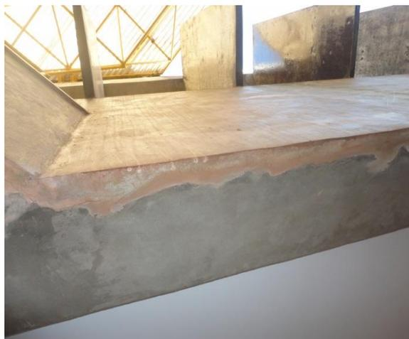
**Figura 63 - Ausência de Pingadeira Viga e Brise**
