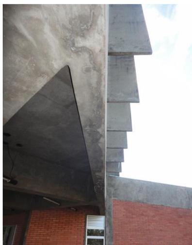
**Figura 65 - Ausência de Pingadeira Viga e Brise**
