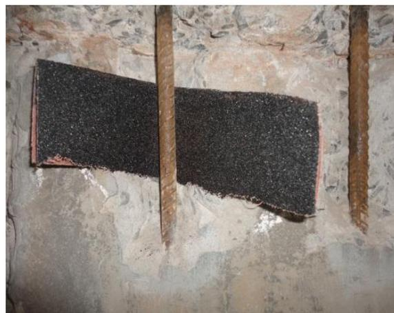
**Figura 89- Limpeza das armaduras com processo abrasivo, lixamento**
