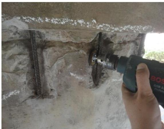
**Figura 88 - Remoção de componentes da corrosão com escova de aço**
