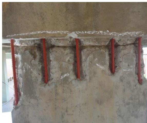
**Figura 91 - Aplicação de revestimento Inibidor de corrosão na armadura Emaco P22 - BASF**
