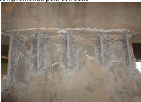
**Figura 92 - Aplicação de adesivo estrutural a base de resina epóxi na armadura, Sikadur 32**
