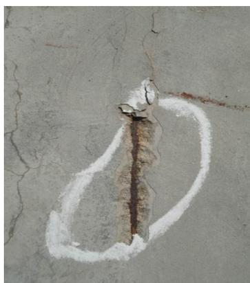
**Figura 43 - Espessura de cobrimento insuficiente, corrosão da armadura na lateral de viga externa**
