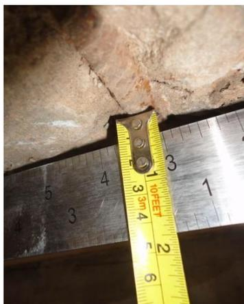
**Figura 49 - Espessura de cobrimento insuficiente, corrosão da armadura em pilar externo**
