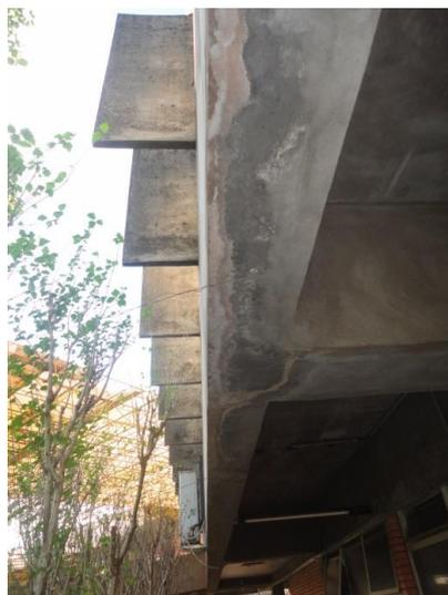
**Figura 64 - Ausência de Pingadeira Viga e Brise**
