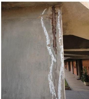
**Figura 47- Espessura de cobrimento insuficiente, corrosão da armadura em pilar externo**
