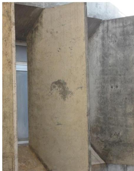
**Figura 96 - Limpeza final da brise com lavagem sob pressão**
