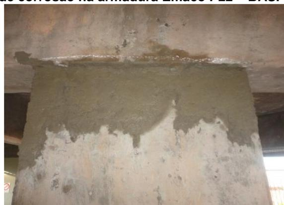
**Figura 93 - Realização de reparo estrutural com argamassa cimentícia com fibra sintética e inibidor de corrosão, Emaco S 88-CI - BASF**
