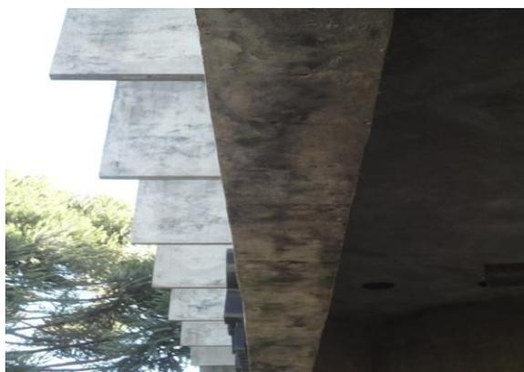
**Figura 67 - Ausência de Pingadeira Viga e Brise**
