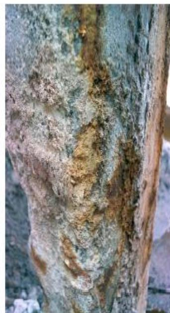
Figura 26 – Degradação apresentada em pilar de estrutura em contato com produtos químicos para fabricação de fertilizantes
