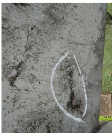
**Figura 54 - Espessura de cobrimento insuficiente, corrosão da armadura em brise externo**
