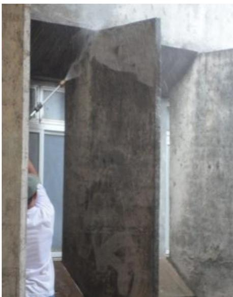
**Figura 95 - Limpeza inicial da brise com lavagem sob pressão**
