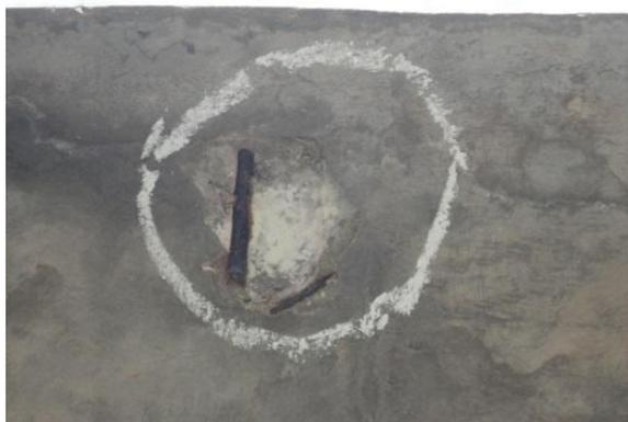
**Figura 17 - Espessura de cobertura insuficiente, corrosão da armadura em borda de viga externa**
