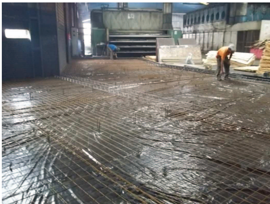
Figura 20 – Montagem da armadura da 2ª etapa do piso Fonte: Autores (2013).
