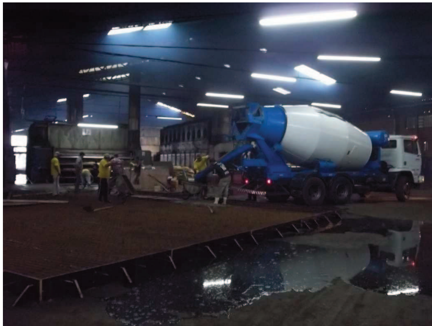
Figura 21 – Início da concretagem Fonte: Autores (2013).
