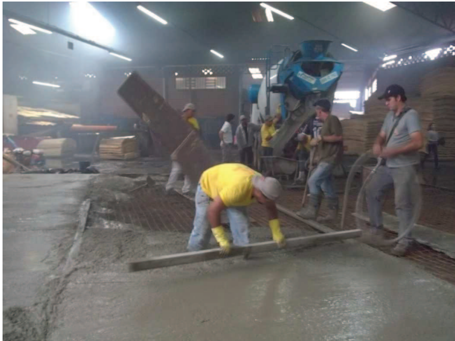
Figura 24 – Terceira etapa de concretagem Fonte: Autores (2013).
