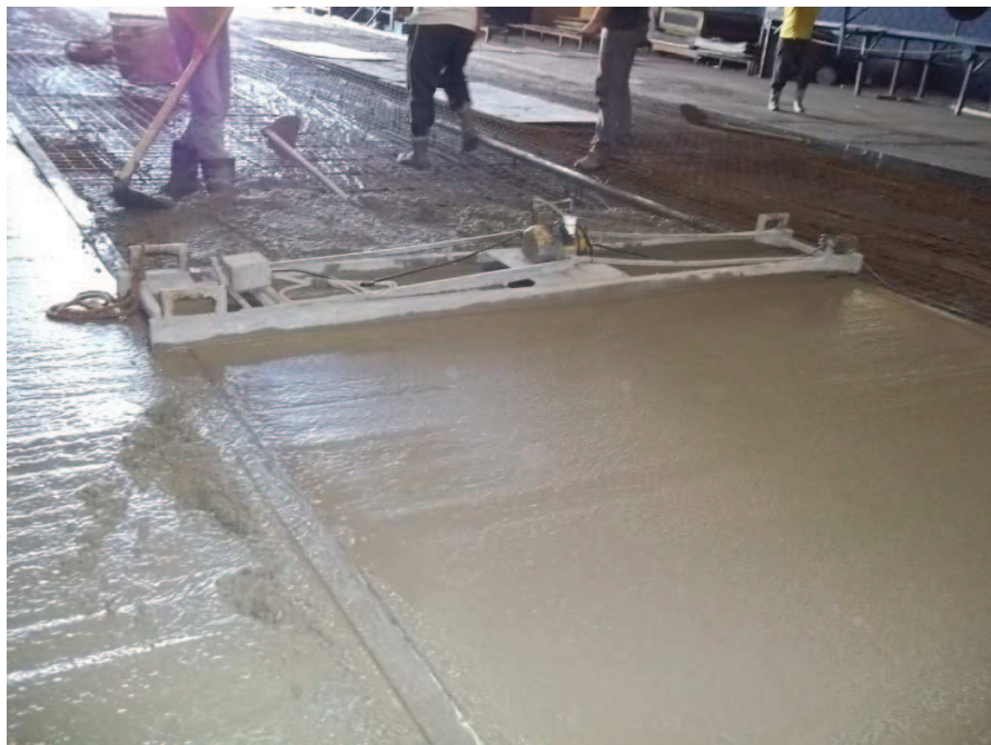
Figura 36 – Concretagem 3ª etapa Fonte: Autores (2013).
