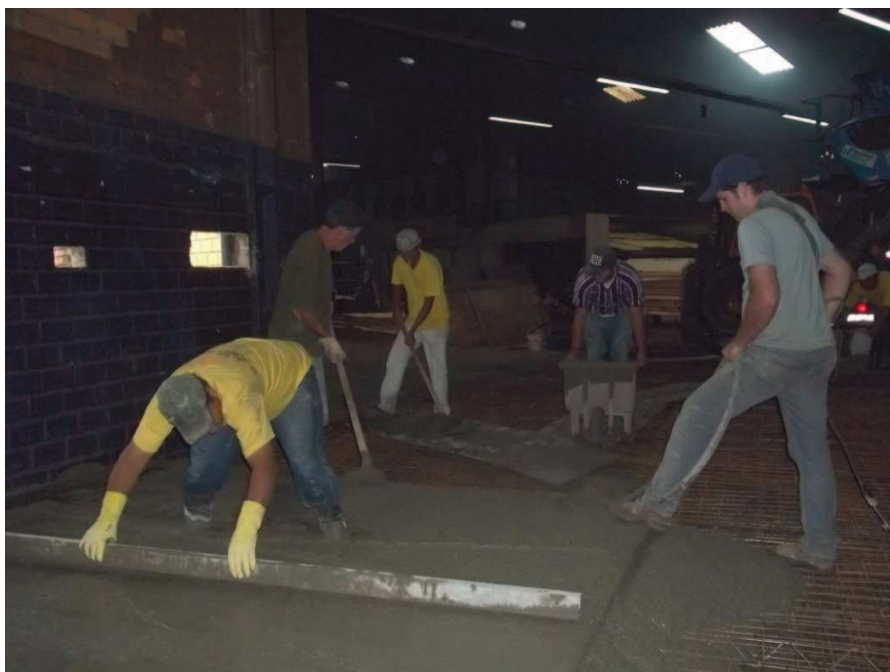
Figura 23 – Segunda etapa de concretagem Fonte: Autores (2013).
