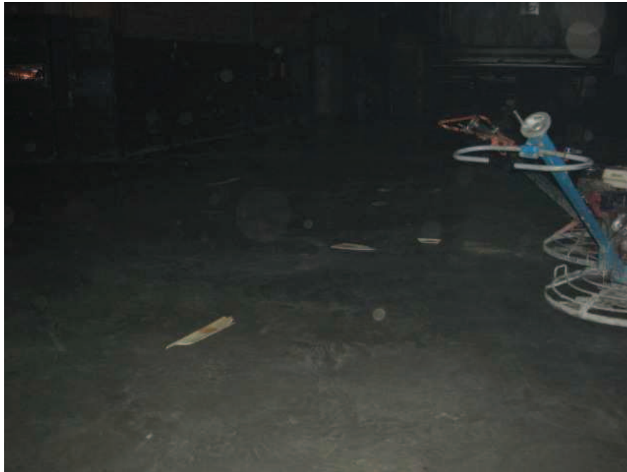
Figura 29 – Finalização do polimento do piso 2ª etapa Fonte: Autores (2013).
