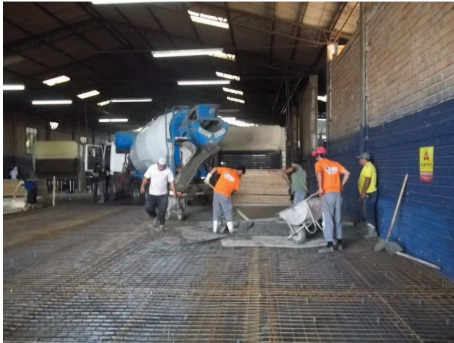
Figura 35 – Início da concretagem 3ª etapa Fonte: Autores (2013).
