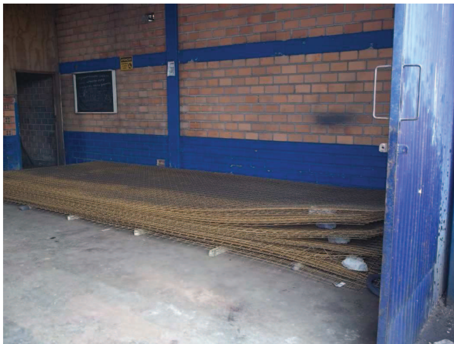
Figura 17 – Local de armazenamento do material Fonte: Autores (2013).
