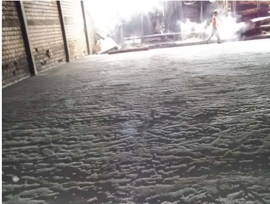
Figura 18 – Piso da 1ª etapa concluído Fonte: Autores (2013).
