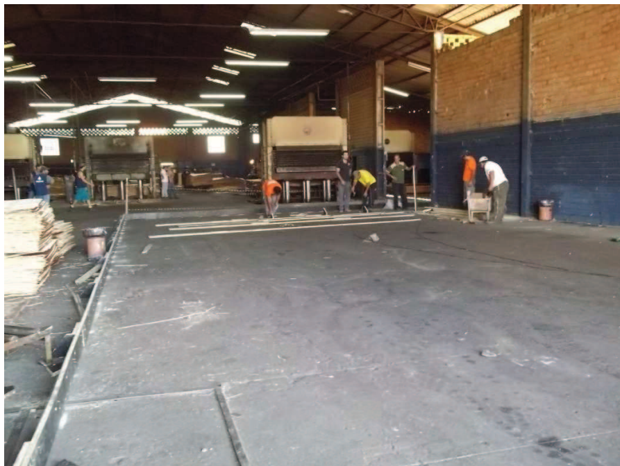
Figura 31 – Montagem das formas 3ª etapa Fonte: Autores (2013).
