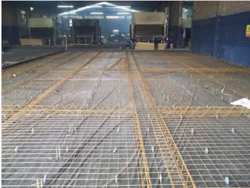
Figura 33 – Montagem da armadura 3ª etapa Fonte: Autores (2013).
