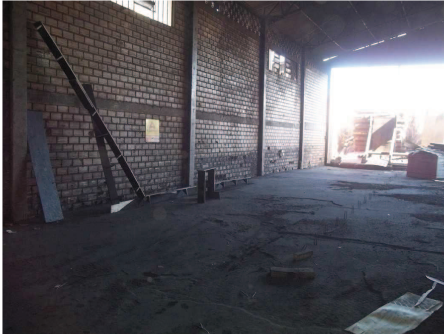
Figura 14 – Preparação da base e taqueamento da área a ser executada Fonte: Autores (2013).
