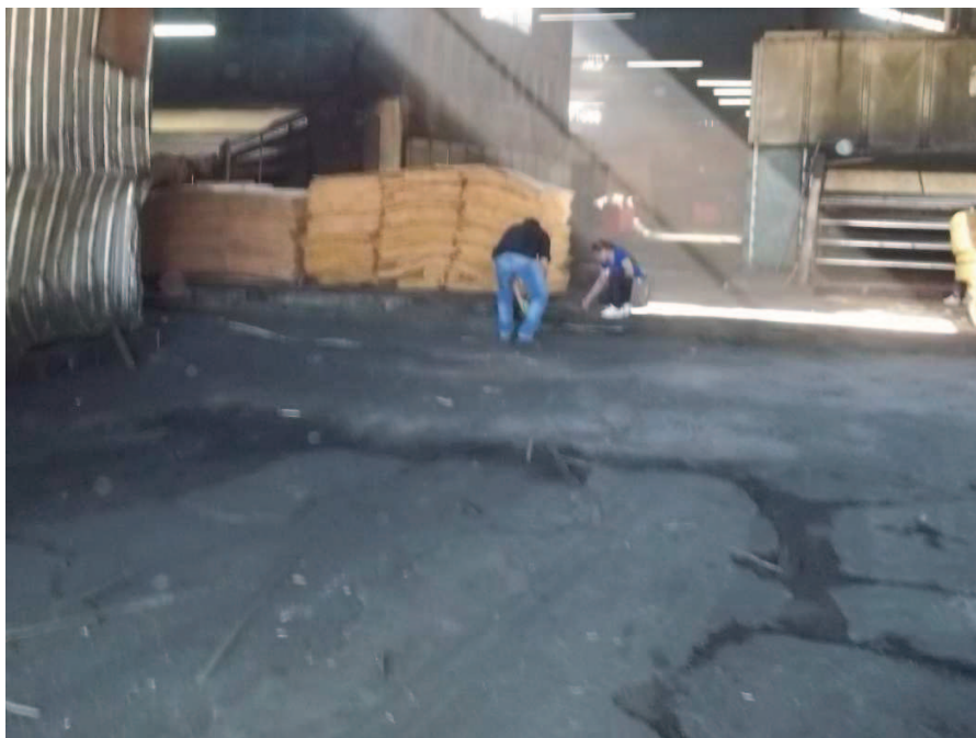
Figura 12 - Situação do piso existente e medição das dimensões do barracão Fonte: Autores (2013).
