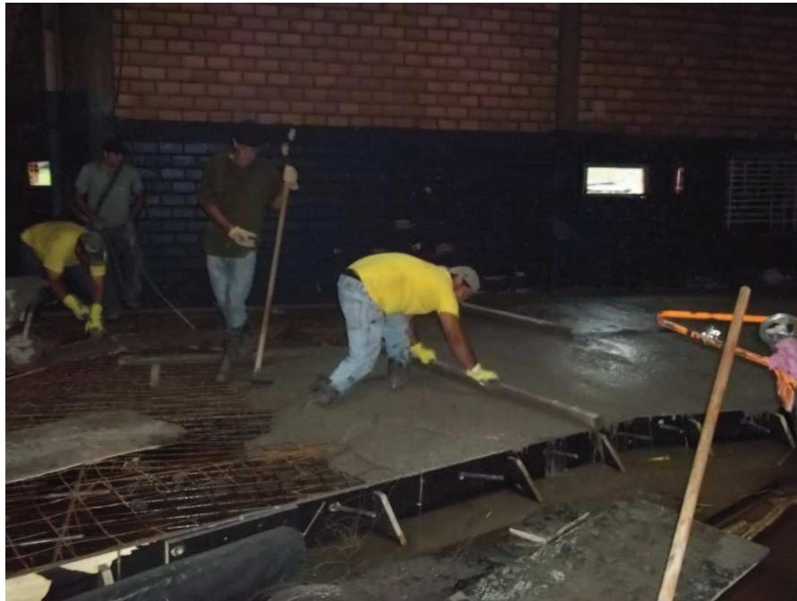
Figura 22 – Primeira etapa de concretagem Fonte: Autores (2013).
