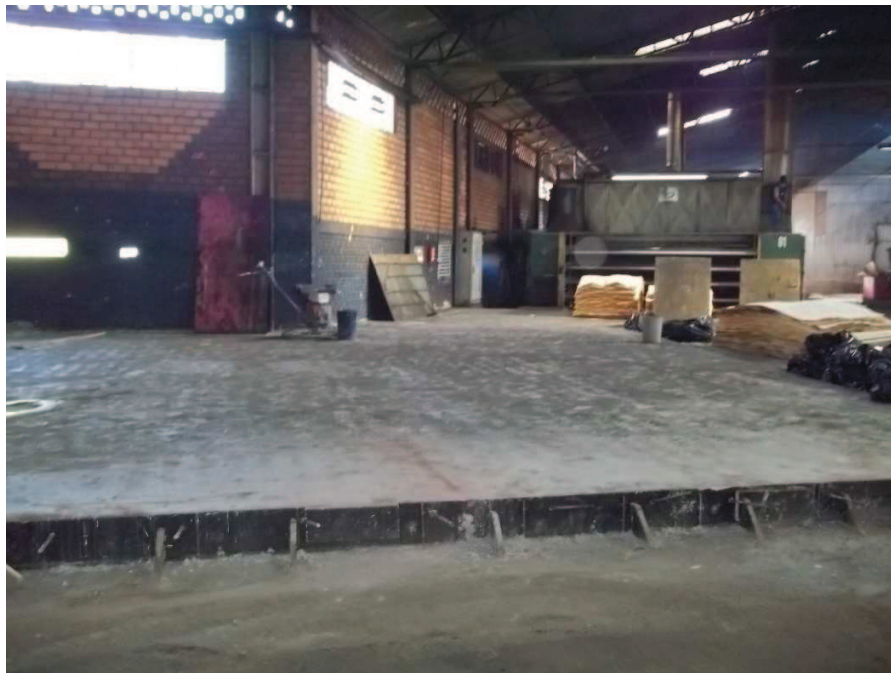
Figura 30 – Piso da 2ª etapa concluído
