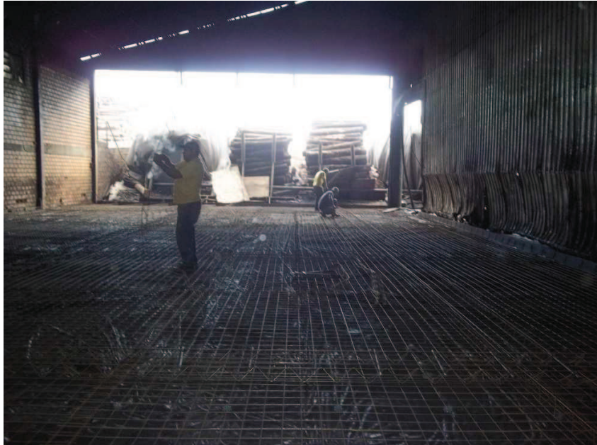
Figura 15 – Montagem das armaduras (1ª etapa) Fonte: Autores (2013).
