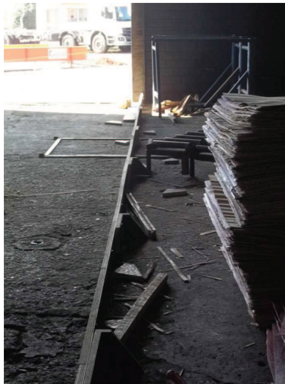
Figura 32 – Conferência do nivelamento e alinhamento das formas Fonte: Autores (2013).
