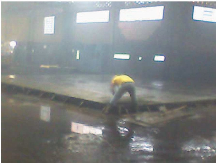
Figura 25 – Quarta etapa de concretagem Fonte: Autores (2013).
