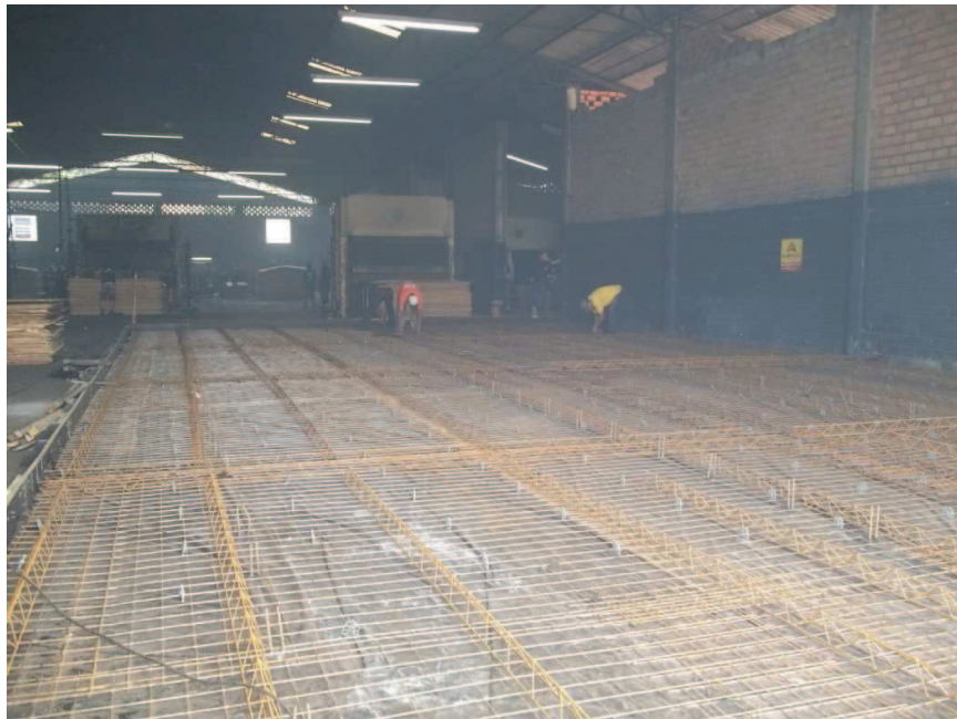
Figura 34 – Colocação das barras de transferência Fonte: Autores (2013).
