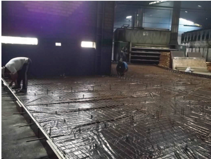
Figura 19 – Montagem das formas e montagem da armadura Fonte: Autores (2013).
