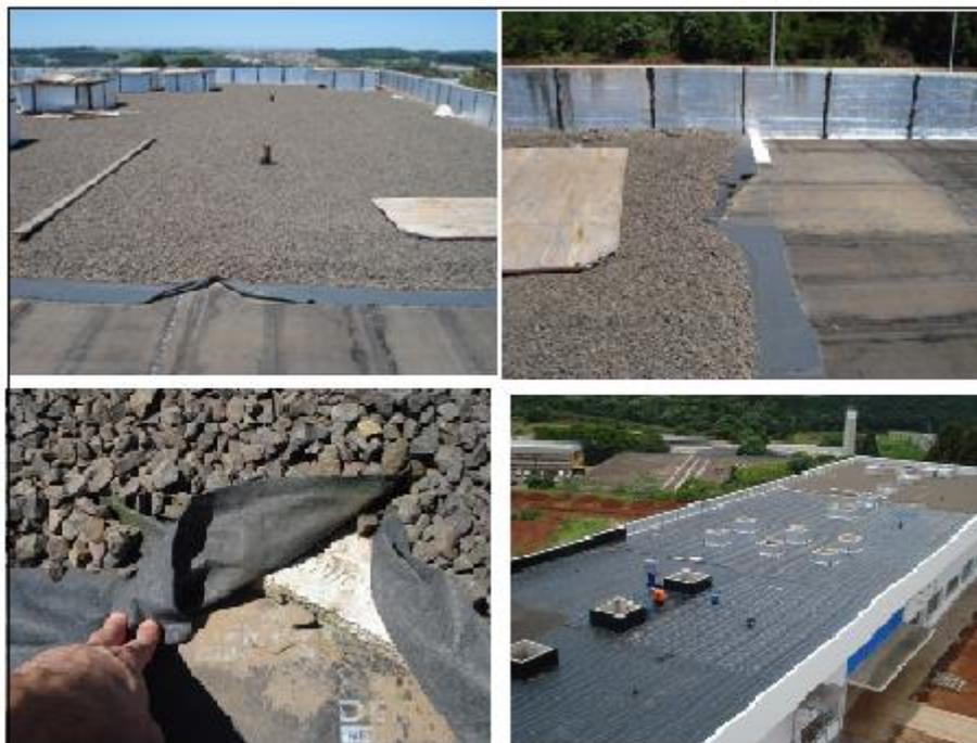
**Figura 12 – preparo e aplicação de manta asfáltica para impermeabilização e lajes**
