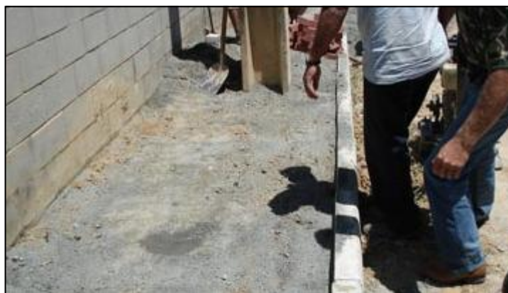
Figura 12: Contenção lateral Fonte: Maski (2013)
