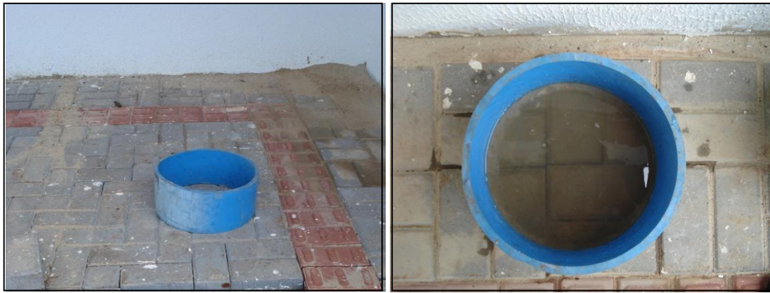
Figura 21: Calçada Parque , a) espinha de peixe b) trama Fonte: Autor (2013)
