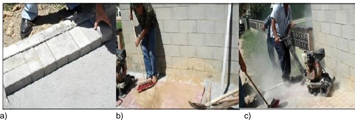
Figura 17: Etapas finais de execução do pavimento Fonte: Adaptado de Maski (2013)
