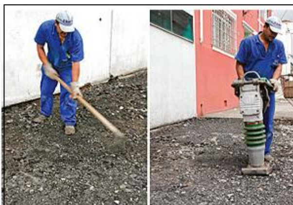
Figura 11: Execução das camadas inferiores Fonte: Equipe de Obra (2013)
