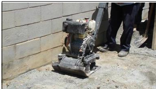
Figura 10: Nivelamento e compactação do subleito Fonte:Maski (2013)
