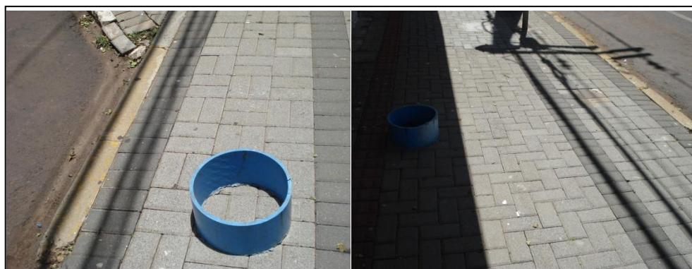
Figura 23: Calçada na Rua Itabira, a) Trama b) Espinha de Peixe
