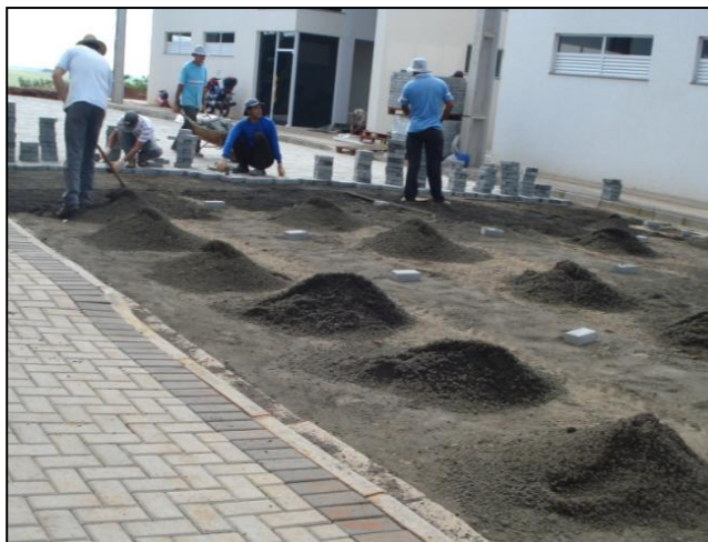
Figura 14: Espalhamento da areia de assentamento Fonte: Autor (2013)
