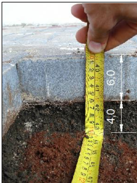
Figura 25: Camadas inferiores Fonte: Autor (2013)
