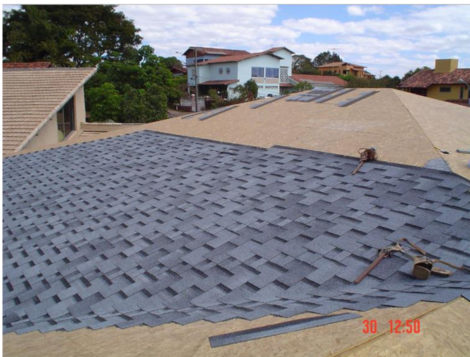
Figura 11: Utilização de placas de OSB em coberturas para aplicação de telhas Shingle. Fonte: TC Shingle, 2004.
