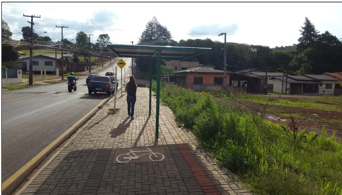
Figura 17 - Ciclofaixa sobre calçada na extensão da Rua Ivai – detalhe de interferências físicas Fonte: Autor (2016).
