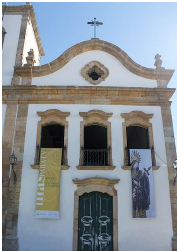
Figura 7: Construção utilizando solo na cidade de Paraty (RJ) Fonte: Libório (2017).
