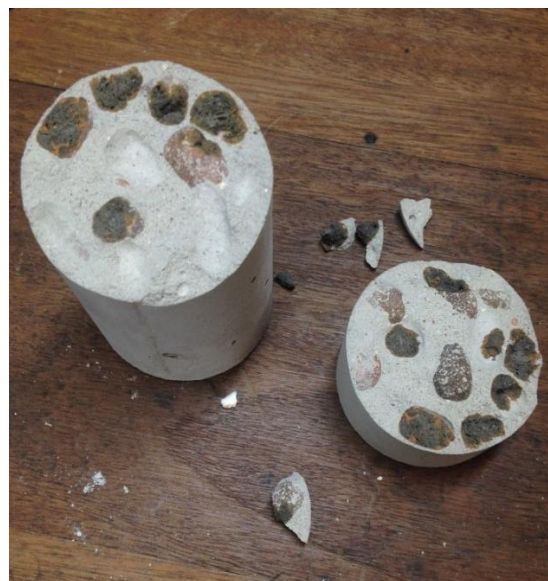
Figura 26 - Seção de ruptura por spalling Fonte: acervo do autor.
