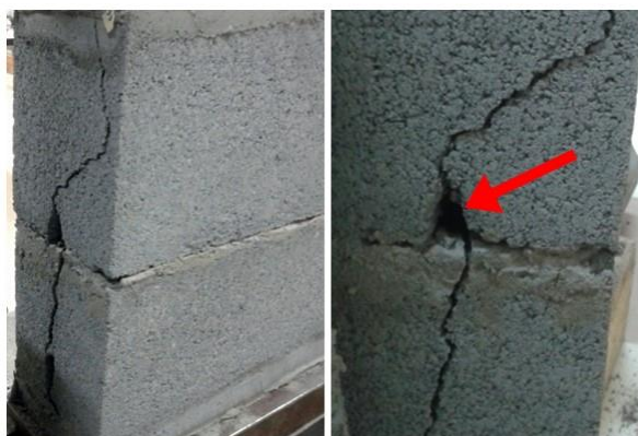
Figura 49 - P1'1, fissuração lateral Fonte: (AUTORIA PRÓPRIA, 2017).
