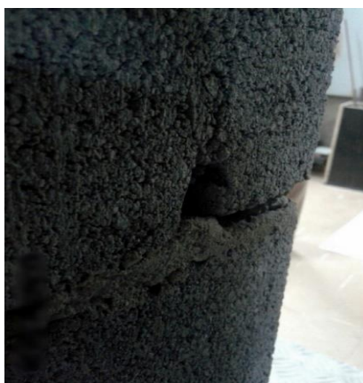
Figura 52 - P2'1, orifício bloco superior Fonte: (AUTORIA PRÓPRIA, 2017).
