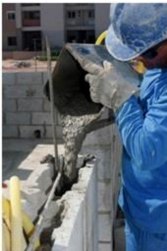
Figura 7 - Grauteamento Fonte: (RIVERS, 2017).
