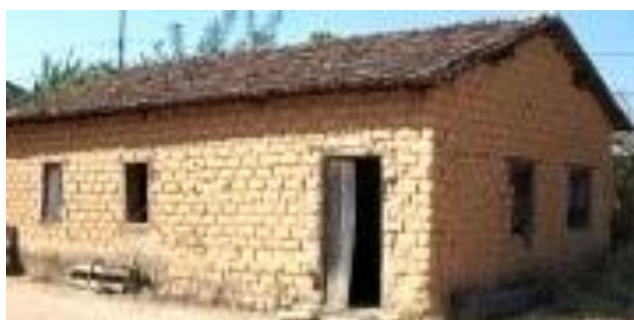
Figura 3 - Casa de tijolo, Rio de Contas, Bahia Fonte: (ALVENARIA DE ADOBE, 2017).
