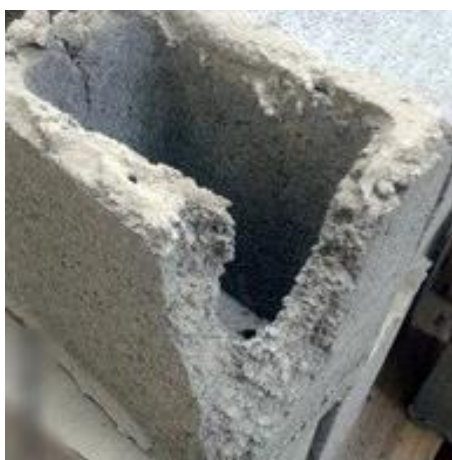
Figura 57 - P2'2 - Colapso parcial do bloco inferior Fonte: (AUTORIA PRÓPRIA, 2017).
