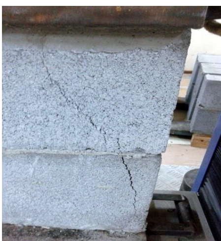
Figura 50 - P2'1, fissuração traseira Fonte: (AUTORIA PRÓPRIA, 2017)
