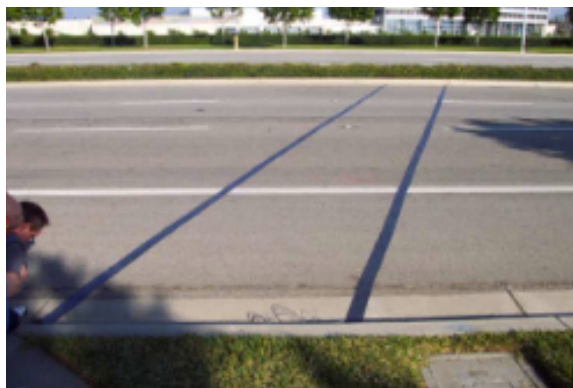
Figura 9 – Disposição de lâminas de sensores de laço indutivo Fonte: Oh, Ritch e Jeng (2007, p.2).
