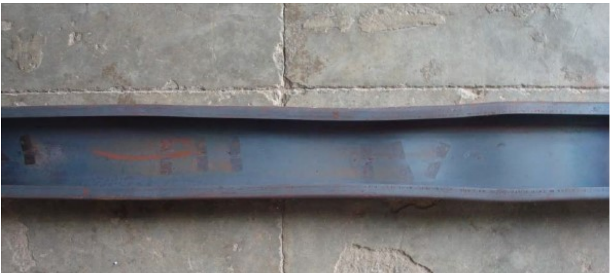
Figura 12 - Falha local na alma e distorcional no conjunto mesa-enrijecedor
