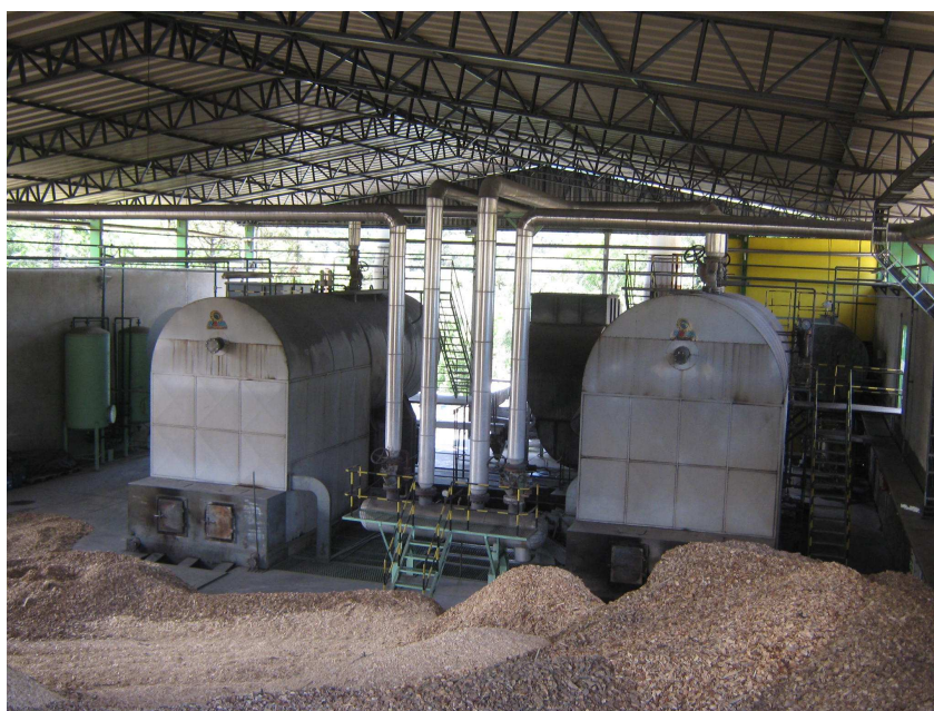
Figura 8: Vista Frontal Prédio da Caldeira.
