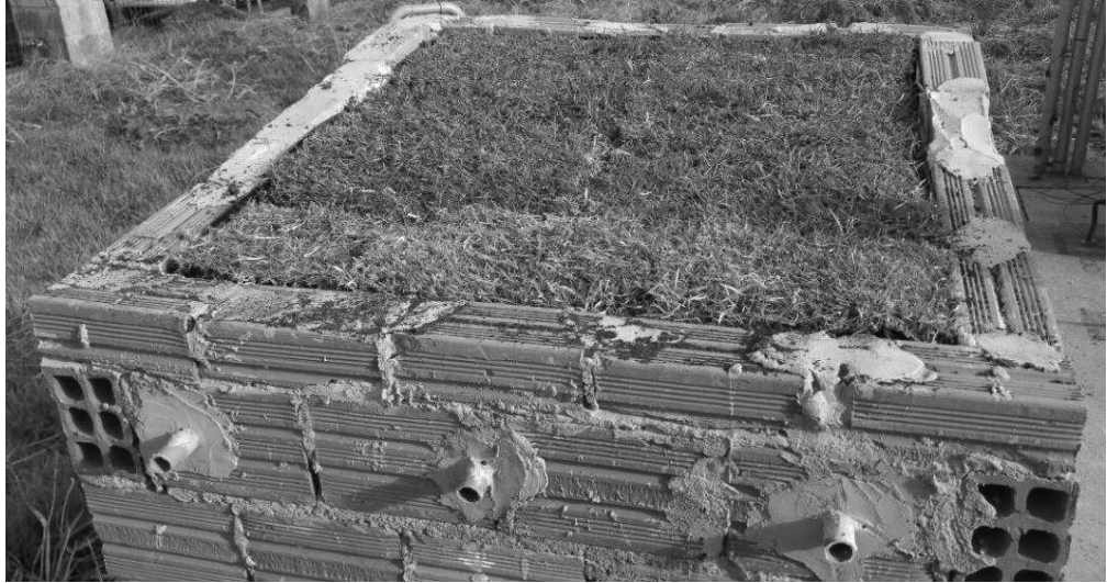
Figura 23: Camada de vegetação finalizada
