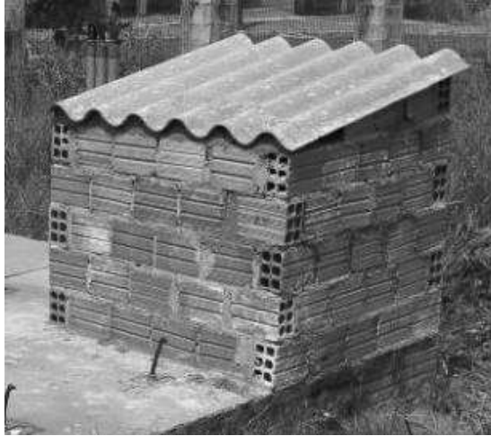
Figura 15: Protótipo com cobertura de fibrocimento executado
