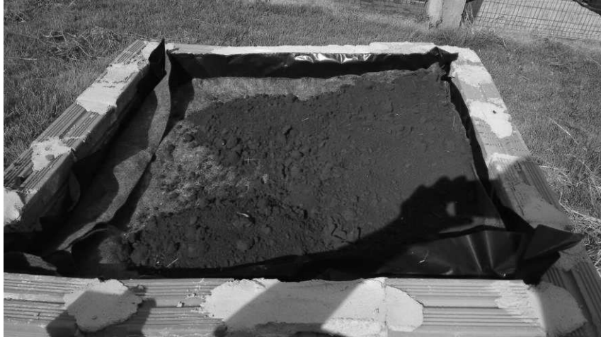
Figura 20: Manta geotêxtil aplicada e início da camada de solo
