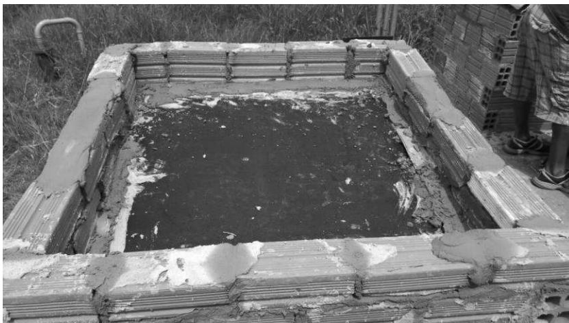
Figura 16: Laje de chapa de compensado executada
