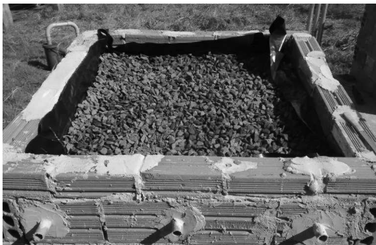
Figura 19: Feita a camada de impermeabilização com lona e camada de pedra brita
