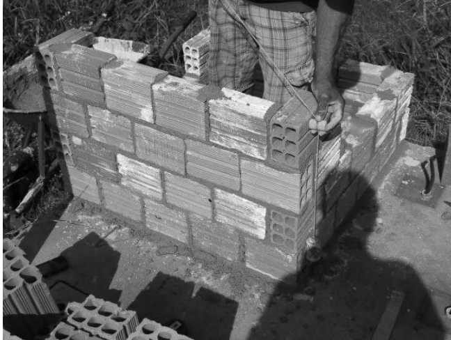
Figura 13: Execução das paredes dos protótipos
