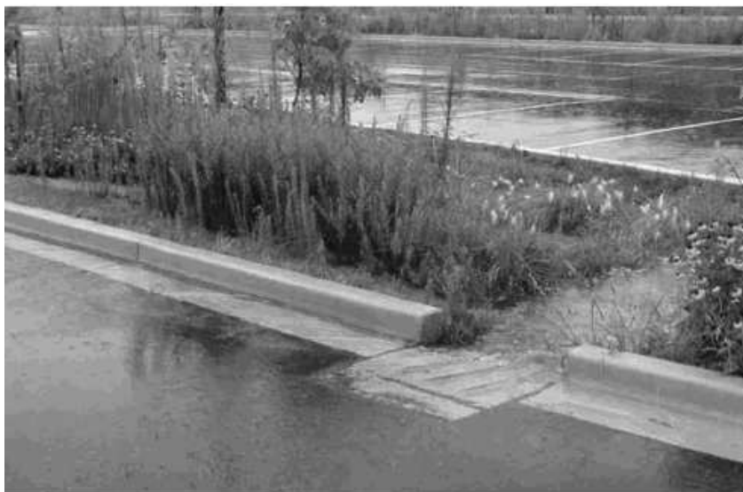
Figura 4 - Área de biorretenção para estacionamento com meio-fio. Fonte: Davis, et al. (2009).
