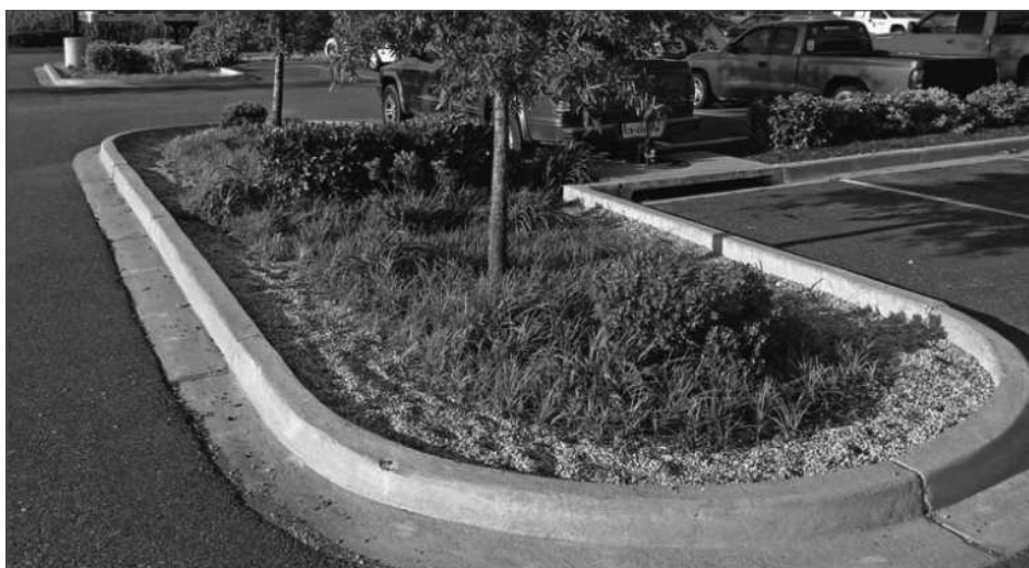
Figura 5 - Área de biorretenção em estacionamento provida de meio-fio. Fonte: Maryland (2012).
