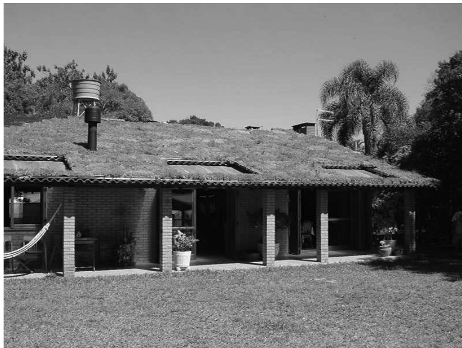
Figura 41 - Telhado Verde Fonte: Mundo das Tribos, 2016.
