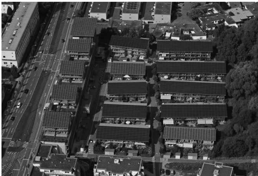
Figura 54 - Painéis Fotovoltaicos do Vauban Fonte: Condomínios Verdes, 2015.
