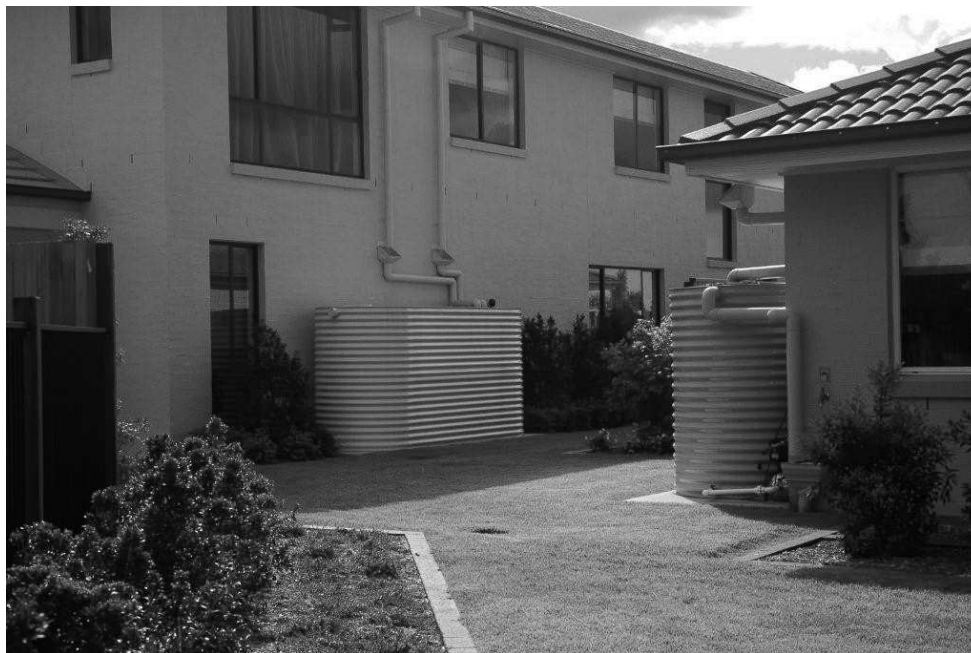
Figura 50 - Reservatórios de água da chuva Fonte: Meu Mundo Sustentável, 2016.
