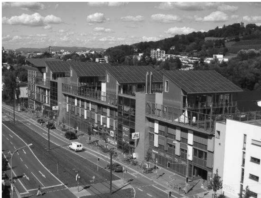
Figura 15 - Painéis fotovoltaicos Fonte: Painterest, 2015.
