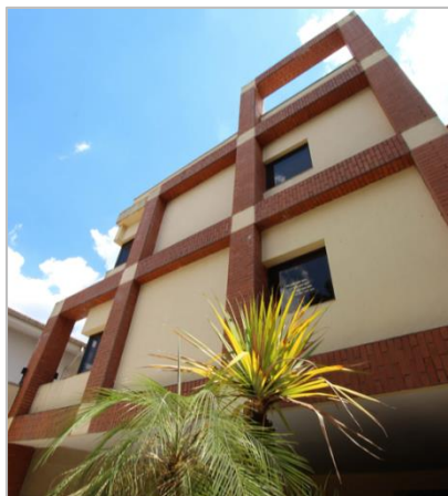
Figura 14 – Edifício MGD Eficiência Energética. Fonte: Autoria Própria.
