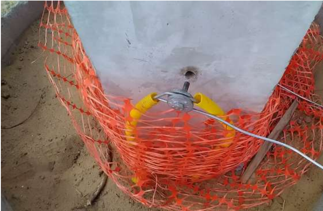
Figura 26– Desacoplamento SPDA / Aterramento.
