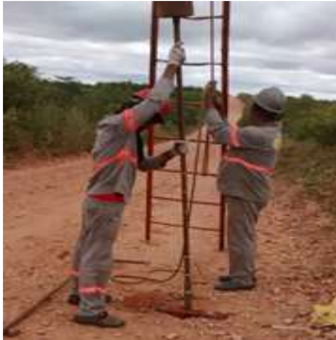
Figura 25– Execução de sondagens.
