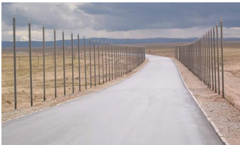
Figura 7 - Tubos de calor utilizados para evitar congelamento de estradas
