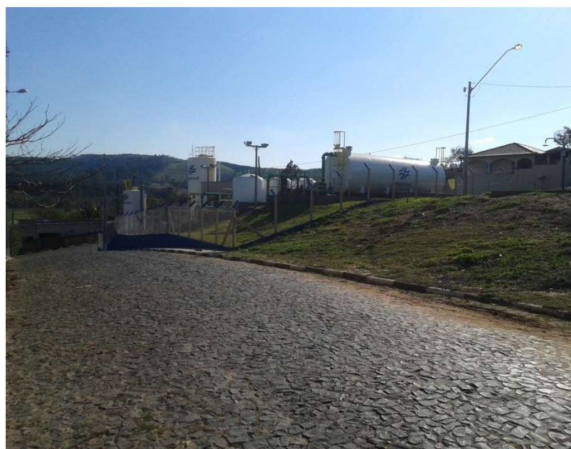
Figura 05 – Sistema de Tratamento
