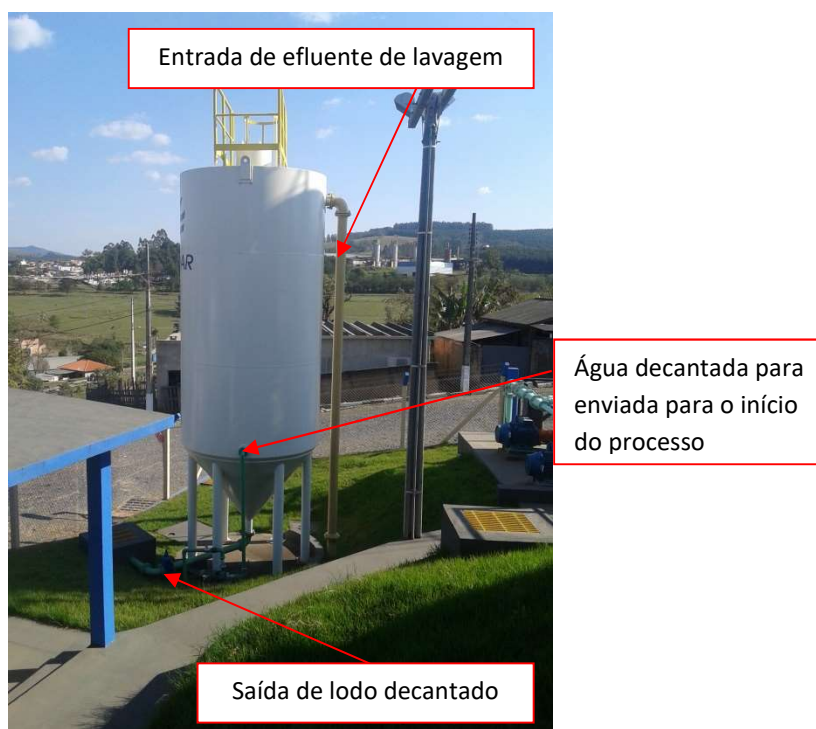
Figura 09 – Decantador de lodo
