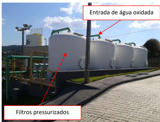
Figura 07 – Filtros pressurizados
