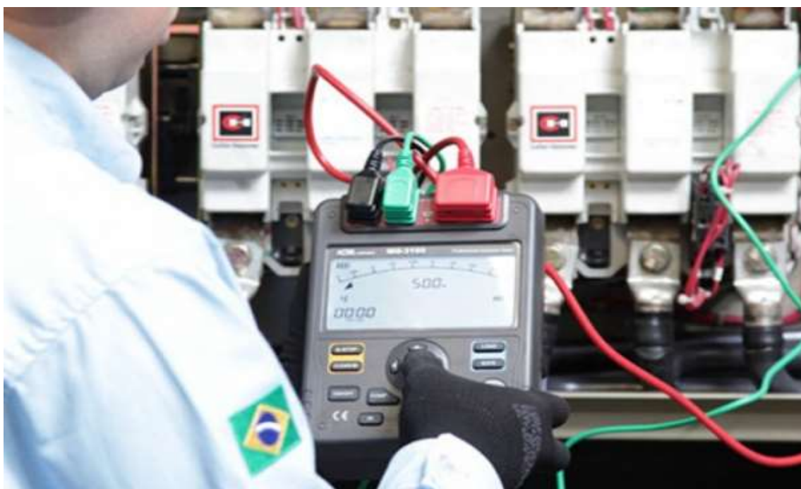
Figura 7 – Manutenção detectiva. Fonte: Industria Hoje, 2012.
