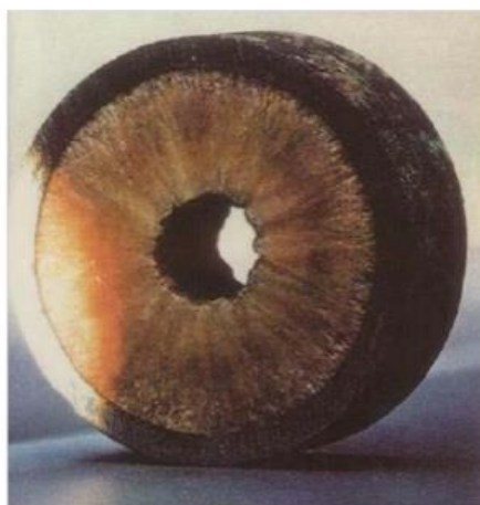
Figura 1 – Duto quase totalmente obstruído por depósito de parafina
