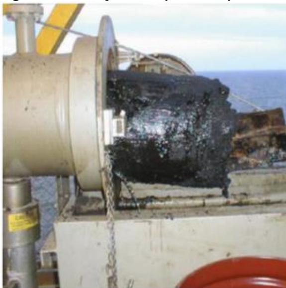
Figura 3 – Remoção de depósito de parafina durante limpeza
